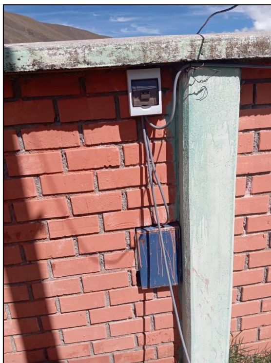
Imagen N°18: TG-1 de la parte eléctrica, de donde se alimenta a los tableros de distribución.
