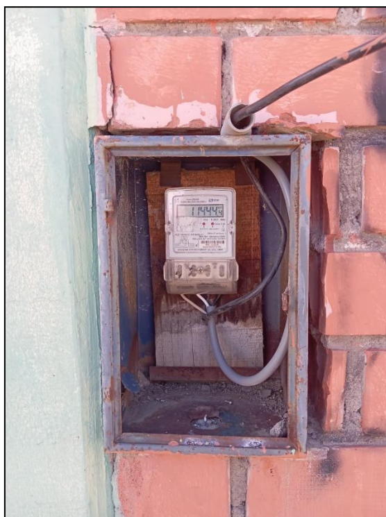
Imagen N°17: Estado en la cual se encuentra el medidor de la institución educativa, ubicado al exterior del muro perimétrico.
