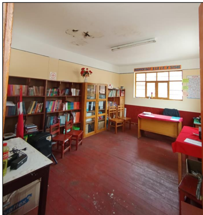
Imagen N°16: En la Dirección de la institución educativa, piso machihembrado, muros tarrajeados y falso cielo raso con yeso.
