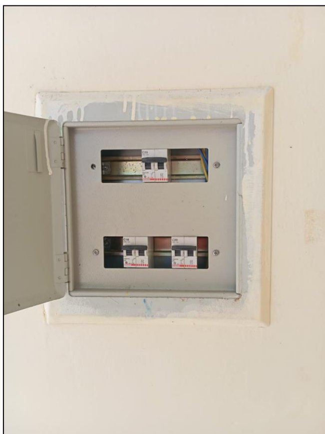
Imagen N°19: Tablero de distribución TD-2 del módulo 2.
