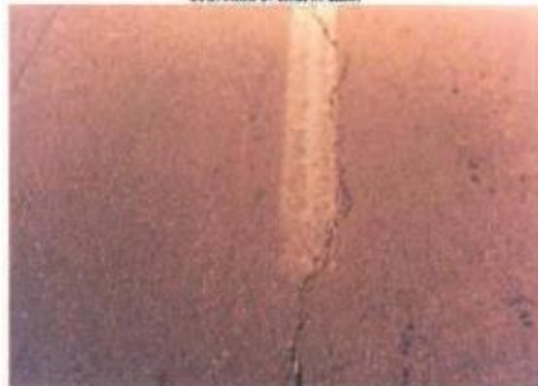
FIGURAS LONGITUDINALES Gravedad 1: fisuras finas
