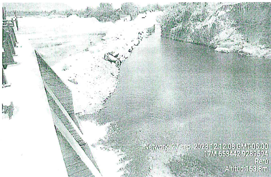
Vista del Rio La Leche, sector Magdalena, donde se aprecia el Tramo 3 donde requiere que el dique se eleve a una altura adecuada y proteger con roca en ambos lados.
