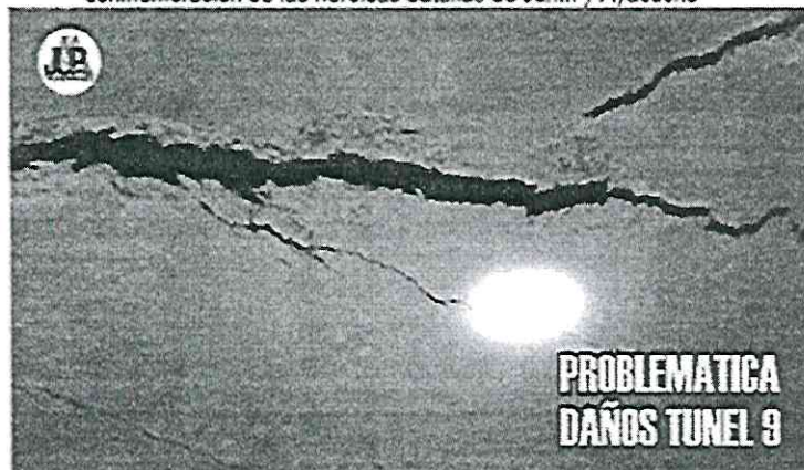
Figura 1.8-3 Desprendimiento del concreto de la bóveda del Túnel 9
