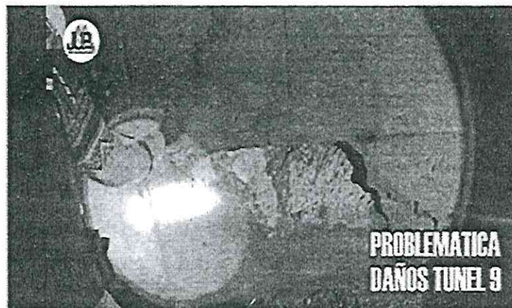
Figura.1.8-2 Desprendimiento en los hastiales del Túnel 9
