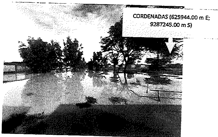
Fotografía N°02: En la imagen se observa claramente el desborde del río abarcando fuera de su cauce natural a consecuencia de la sedimentación de residuos sólidos en la parte central del eje por lo que se plantea la limpieza, descolmatación en la parte central en sección transversal, con la finalidad de estabilizar los taludes laterales en ambas márgenes.
