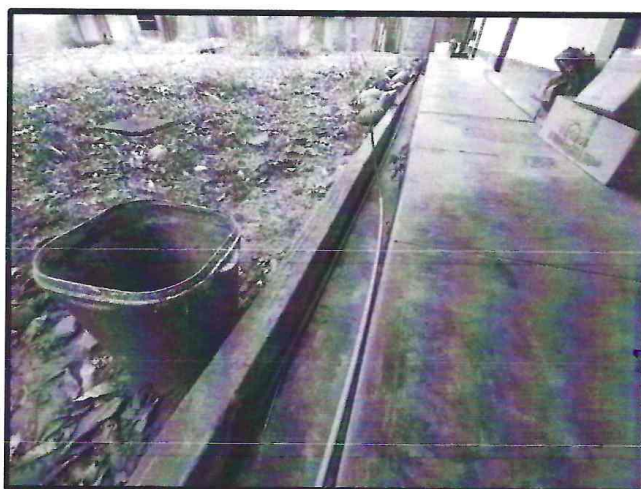
FOTO 06 – (17-03-2023) Se observa en la imagen la tubería de agua expuesta, el cual es necesario enterrarla para evitar futuros accidentes.
