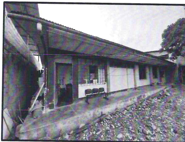
FOTO 03 – (17-03-2023) Se observa en la imagen el deteriorado estado de la pintura en la fachada posterior del establecimiento.
