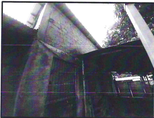
FOTO 07 – (17-03-2023) Se observa en la imagen la fachada posterior el cual es necesario el tarrajeo así como también se aprecia la cobertura del garaje en muy mal estado.
