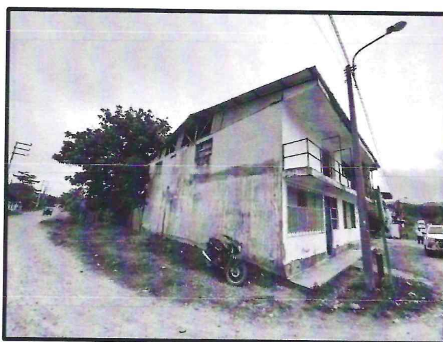
FOTO 02 – (17-03-2023) Se observa en la imagen otra perspectiva de la fachada principal del establecimiento de salud en donde se aprecia el techo en mal estado y la falta de canaletas, así como la pintura deteriorada
