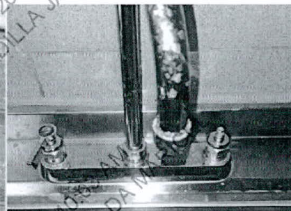
Grifería deteriorada y sin manija.
