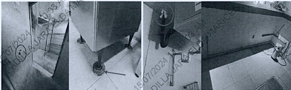
Paredes internas de congelador. Patas oxidadas en máquina de hielo. Pases de tuberías defectuosos. Tuberías expuestas en pared de barra
