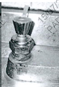
Grifería con corrosión.
