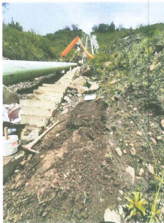
Gráfico N°04: Excavación Manualmente a Cielo abierto.
