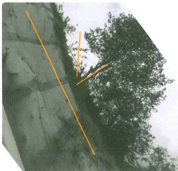
Foto 11: Posible deslizamiento rotacional planar talud margen derecho, progresiva 0+020
