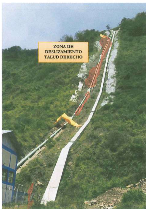
Foto 7: Zona de afectada por deslizamiento planar
