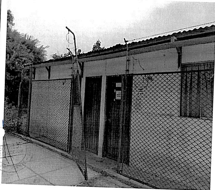
Cerco perimétrico, dañado, oxidado
