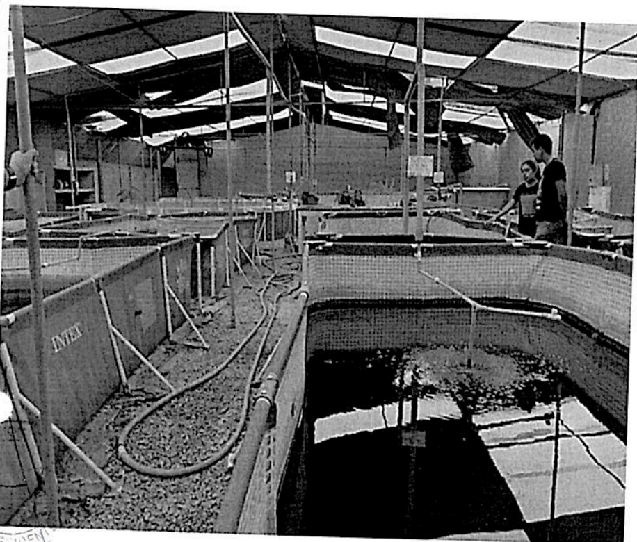
Cubierta en mal estado, estructuras oxidadas sin mantenimiento
