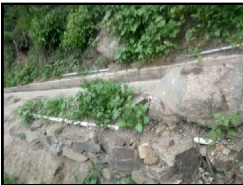
Imagen N° 02: Línea de conducción expuesto a la intemperie
