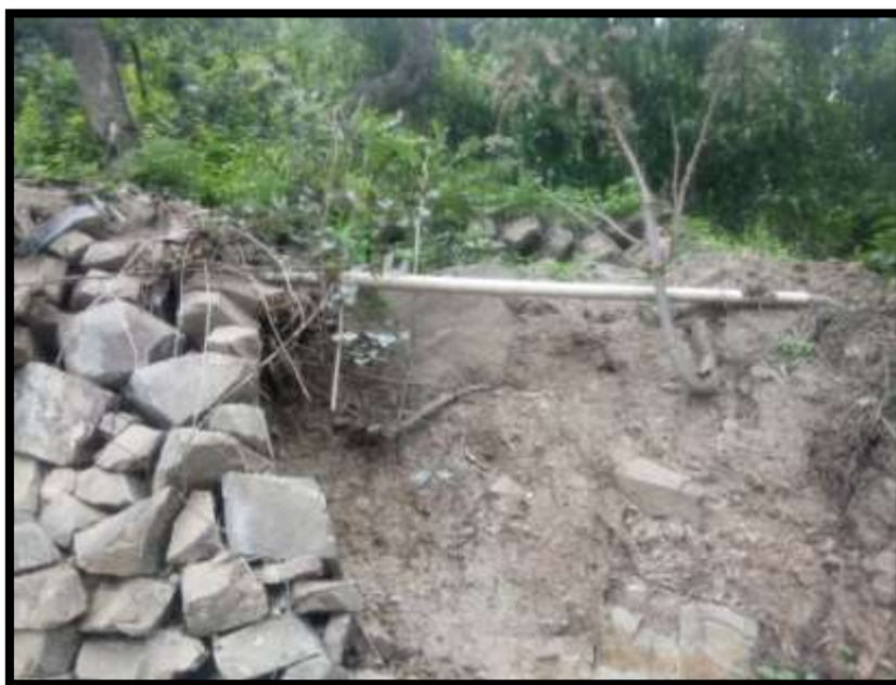
Imagen N° 01: Línea de conducción necesita ser cambiado y protegido con tubería galvanizado.
