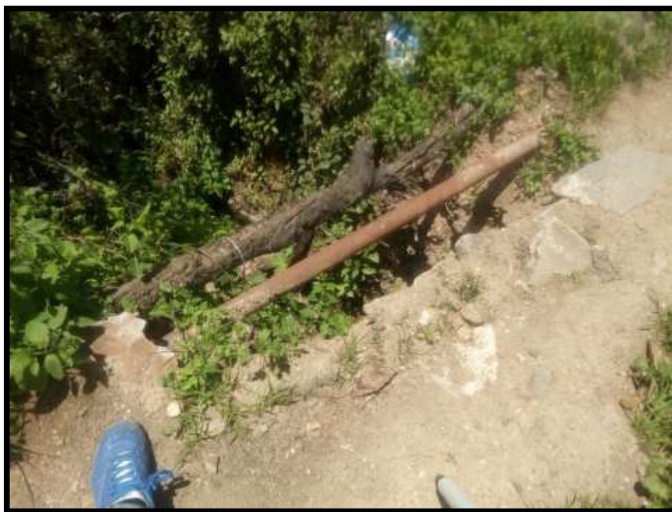
Imagen N° 04: Línea de conducción, necesita protección de fierro galvanizado.
