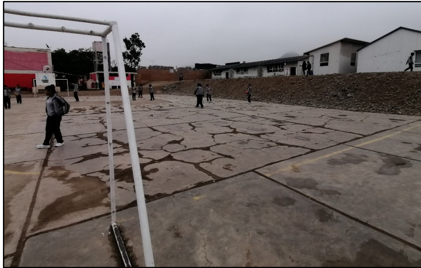
Imagen N°42: Se aprecian los paños de la plataforma deportiva en mal estado a intervenir.
