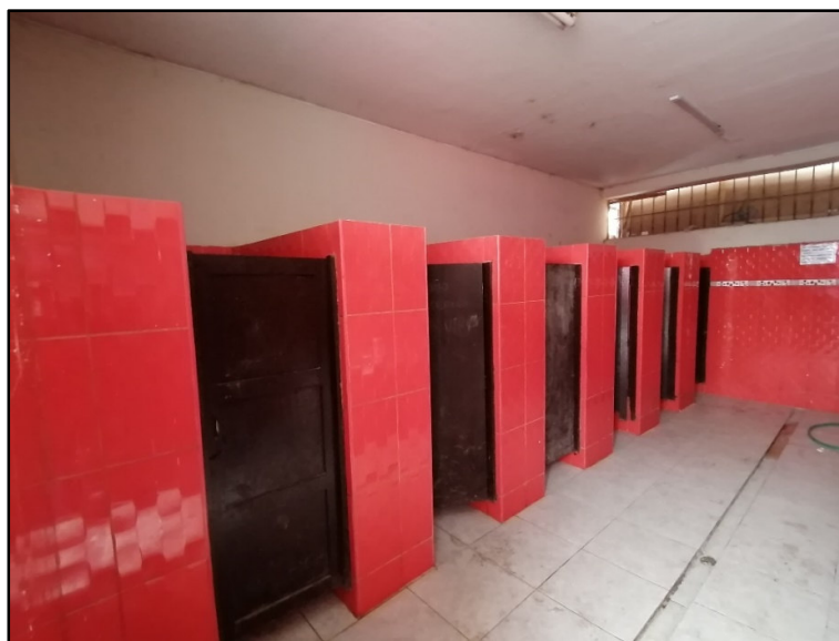
Imagen N°26: Vista del SS.HH. Primaria – Mujeres a Intervenir, se aprecian las puertas de cubículos a realizar mantenimiento así como en la pintura de paredes, cambio de luminarias, instalación de rejilla en piso.
