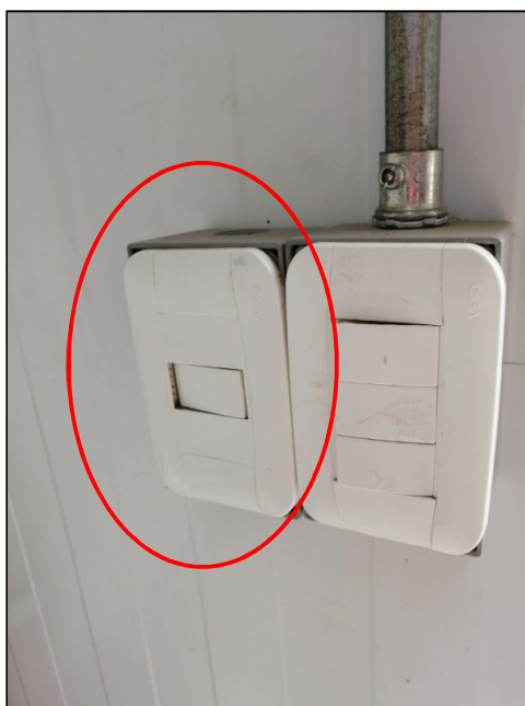
Imagen N°18: Cambio de interruptores deteriorados
