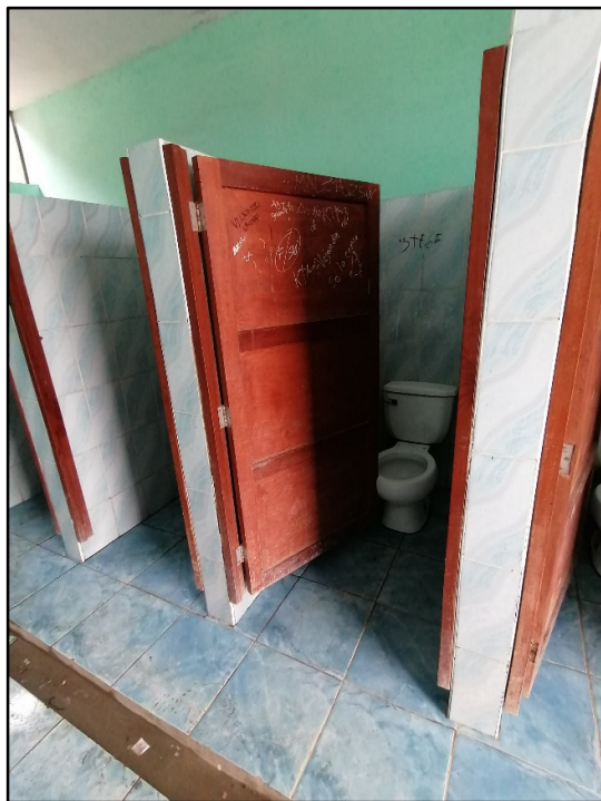
Imagen N°36 – N°37: Vista Interior del SS.HH. Secundaria – Varones a Intervenir, se aprecian la falta de mantenimiento en pintura interior de paredes y techo, así como las puertas de los cubículos no cuentan con el radio de giro adecuado.
