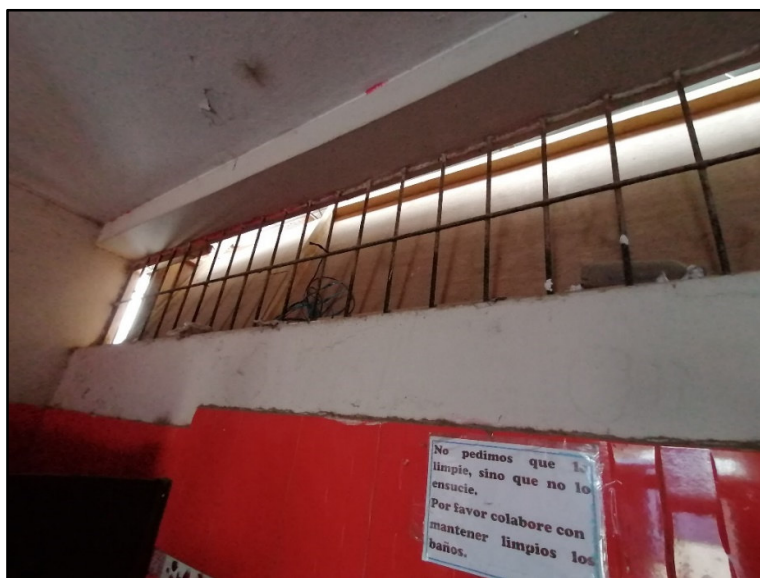
Imagen N° 27: Vista del SS.HH. Primaria – Mujeres a Intervenir, se aprecian la falta de mantenimiento en las ventanas de hierro y pintura interior de paredes y techo.
