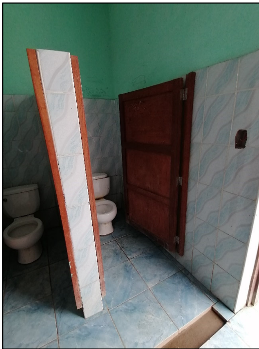
Imagen N°36 – N°37: Vista Interior del SS.HH. Secundaria – Varones a Intervenir, se aprecian la falta de mantenimiento en pintura interior de paredes y techo, así como las puertas de los cubículos no cuentan con el radio de giro adecuado.
