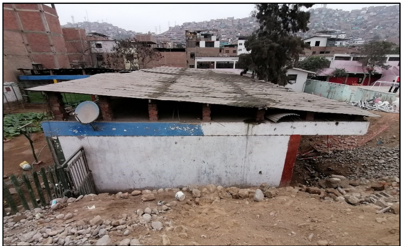
Imagen N°22: Vista de la Cobertura de calaminas de Pabellón de Talleres a Intervenir, en mal estado de conservación, se aprecia además los dados de ladrillo por desmontar.
