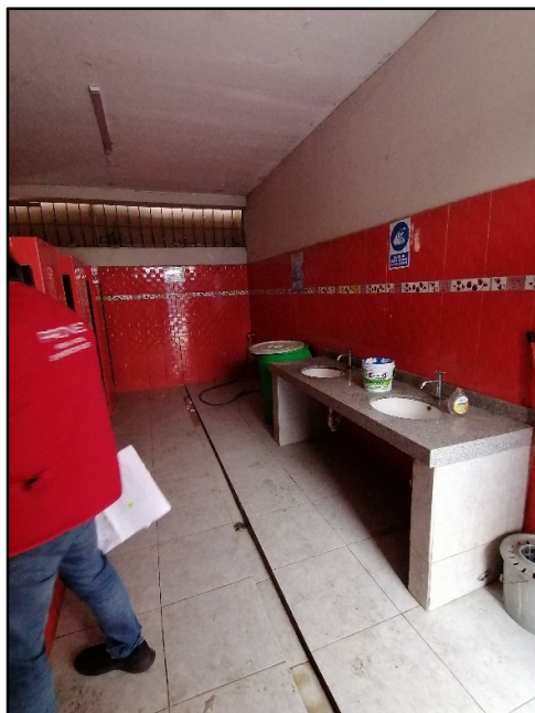
Imagen N° 28: Vista del SS.HH. Primaria-Mujeres a Intervenir. Se aprecia la falta de rejilla en piso.
