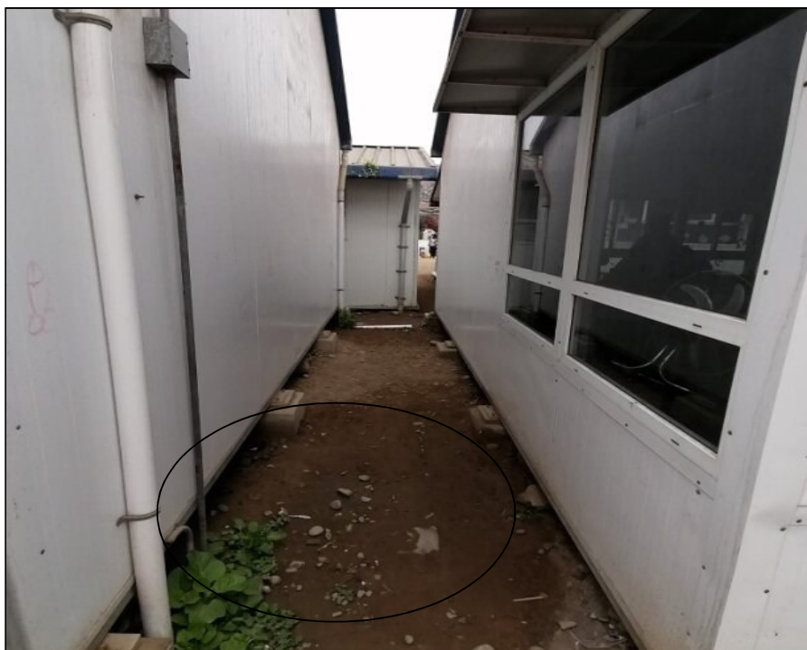
Imagen N°13: Pozos a tierra para mantenimiento semi enterrados
