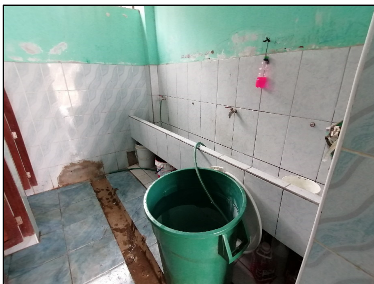
Imagen N°34: Vista Interior del SS.HH. Secundaria – Mujeres a Intervenir, se aprecian la falta de mantenimiento en pintura interior de paredes, así como la falta de rejilla en piso.
