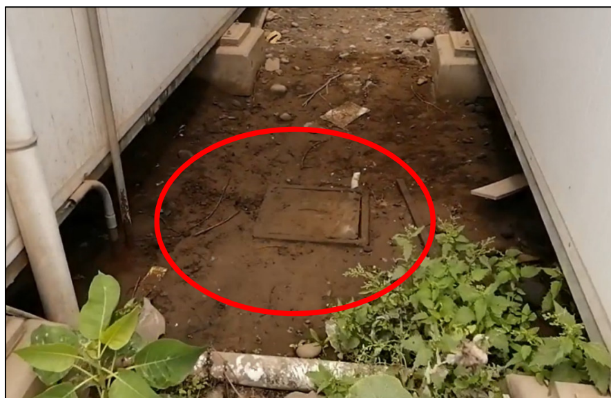
Imagen N°15: Pozo a tierra típico de los módulos del 14 al 23
