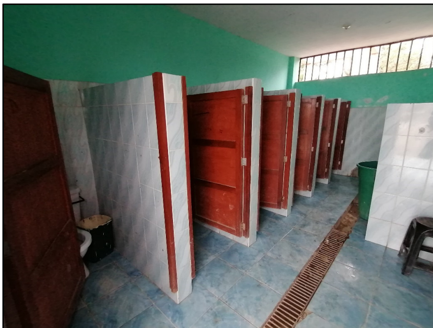
Imagen N°33: Vista Interior del SS.HH. Secundaria – Mujeres a Intervenir, se aprecian la falta de mantenimiento en las ventanas de fierro, en pintura interior de paredes y techo, así como las puertas de los cubículos no cuentan con el radio de giro adecuado.
