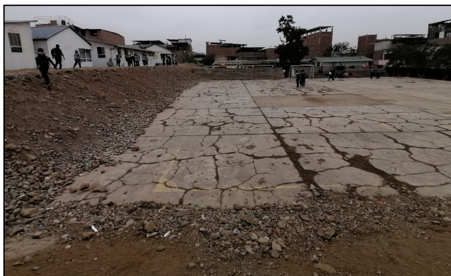
Imagen N° 41: Se aprecian los paños de la plataforma deportiva en mal estado a intervenir.
