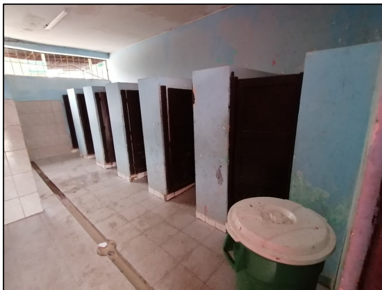
Imagen N° 29: Vista Interior del SS.HH. Primaria – Varones a Intervenir, se aprecian la falta de mantenimiento en las ventanas de fierro, pintura interior de paredes y techo, así como la falta de mantenimiento de las puertas de cubículos.
