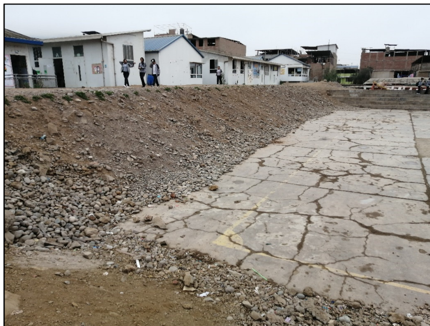
Imagen N° 40: Se aprecian los paños de la plataforma deportiva en mal estado a intervenir.
