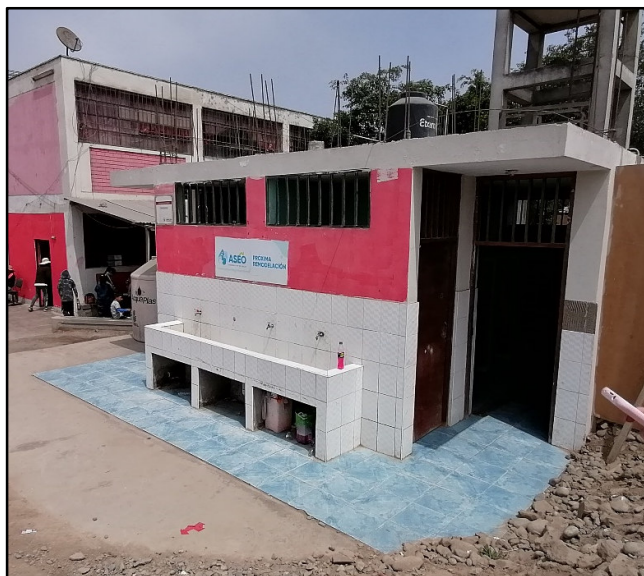
Imagen N°31: Vista Exterior de los SS.HH. de Secundaria a Intervenir con mantenimiento de: Pintura exterior, interior, cambio de griferías, cambio de luminarias, etc.
