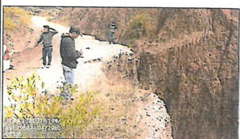
Foto 28: Punto de control - Perdida de plataforma Progresiva 57+260
