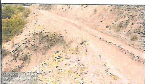
Foto 39: Daño en afirmado y pérdida de plataforma Progresiva 67+520
