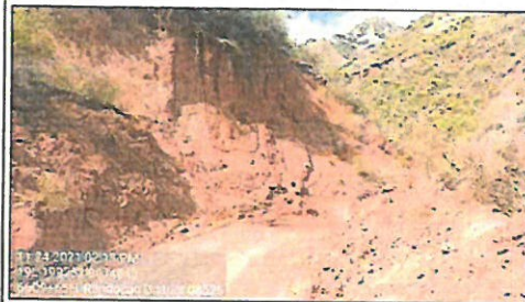
Foto 25: Daño en afirmado y derrumbe Progresiva 55+440
