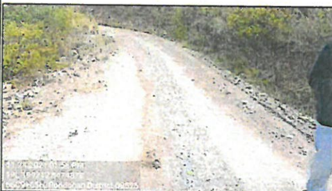
Foto 27: Daño en afirmado Progresiva 56+780
