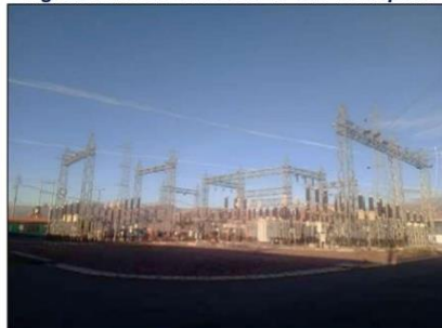
Fig. 23. Transformador de 50 MVA, 220/66/10kV de la SET Mollepatá.
