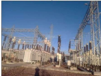
Fig. 23. Transformador de 50 MVA, 220/66/10kV de la SET Mollepatá.
