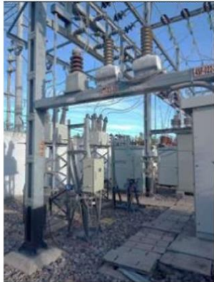
Fig. 18. Patio de llaves en 10 kV de la SET Huanta – Equipo existentes.
