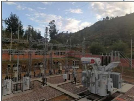
Fig. 19. Patio de llaves en 22.9 kV de la SET Cangallo.
