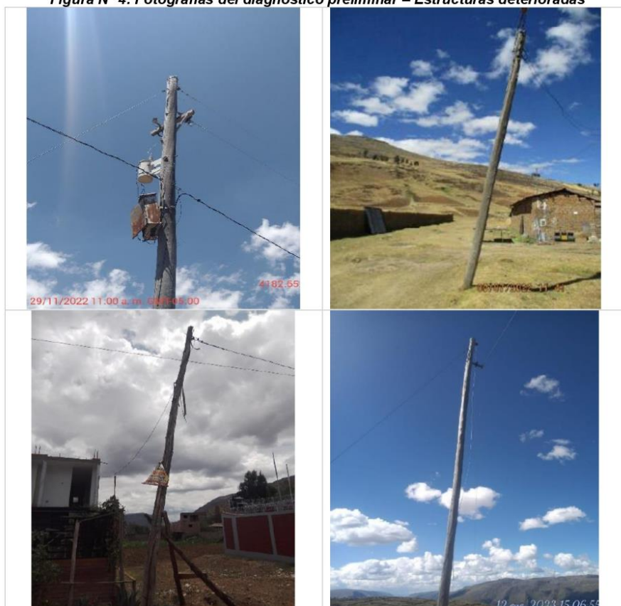
Figura N° 4: Fotografías del diagnóstico preliminar – Estructuras deterioradas
