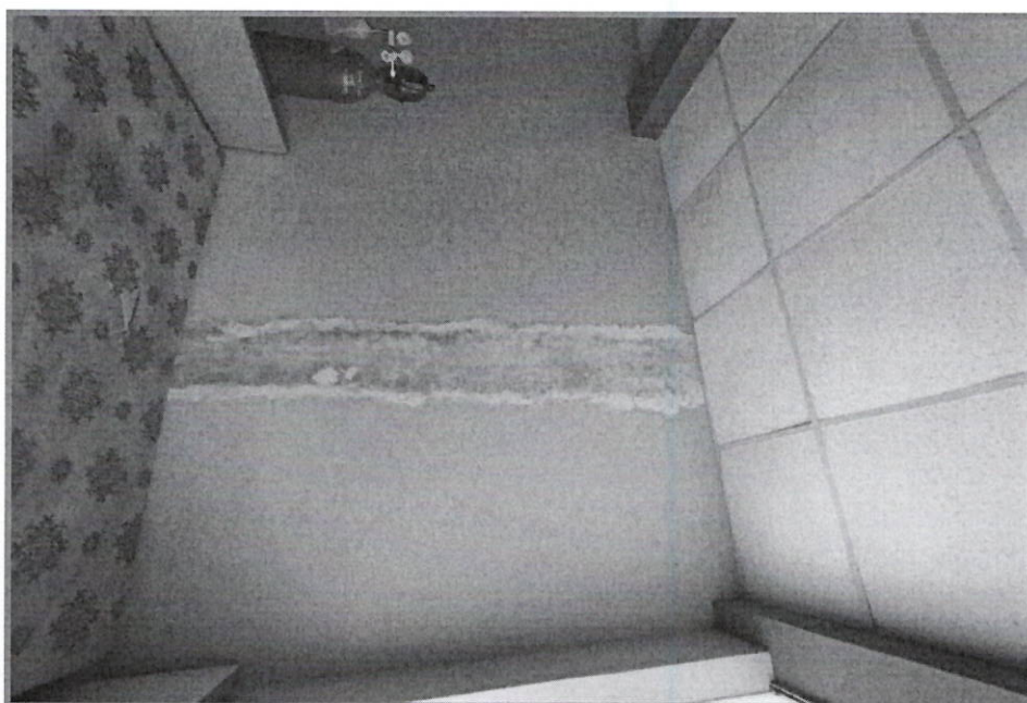
Vista fotográfica: Paredes con la pintura maltratada por filtraciones de agua. Proyecto: MANTENIMIENTO Y/O REMODELACIÓN DE AMBIENTES ASISTENCIALES DEL CENTRO DE SALUD DE HUARIBAMBA CATEGORÍA I-3 DEL DISTRITO DE HUARIBAMBA – PROVINCIA DE TAYACAJA – REGIÓN HUANCAMELICA.
