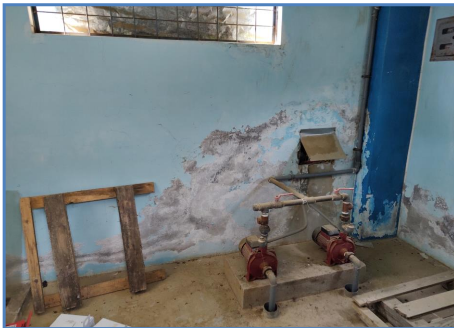
Vista fotográfica: Tanque elevado y tanque cisterna sin mantenimiento . Proyecto: MANTENIMIENTO Y/O REMODELACIÓN DE AMBIENTES ASISTENCIALES DEL CENTRO DE SALUD DE HUARIBAMBA CATEGORÍA I-3 DEL DISTRITO DE HUARIBAMBA – PROVINCIA DE TAYACAJA – REGIÓN HUANCAMELICA.
