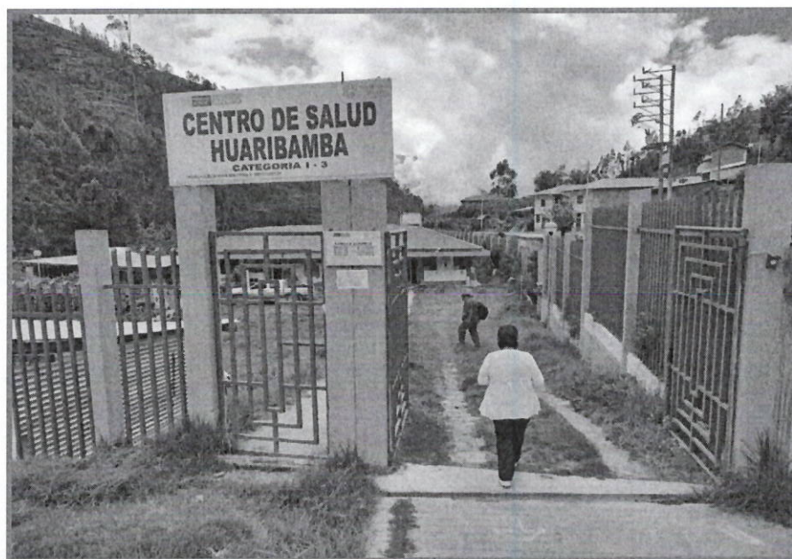
Vista fotográfica: Acceso peatonal sin presencia de barandas . Proyecto: MANTENIMIENTO Y/O REMODELACIÓN DE AMBIENTES ASISTENCIALES DEL CENTRO DE SALUD DE HUARIBAMBA CATEGORÍA I-3 DEL DISTRITO DE HUARIBAMBA – PROVINCIA DE TAYACAJA – REGIÓN HUANCARELICA.
