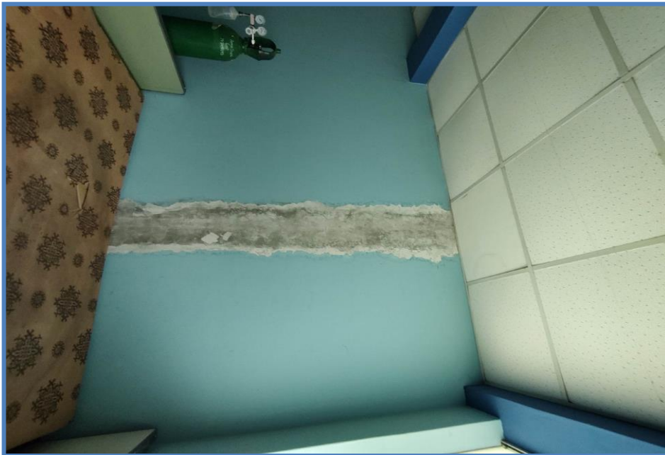
Vista fotográfica: Paredes con la pintura maltratada por filtraciones de agua. Proyecto: MANTENIMIENTO Y/O REMODELACIÓN DE AMBIENTES ASISTENCIALES DEL CENTRO DE SALUD DE HUARIBAMBA CATEGORÍA I-3 DEL DISTRITO DE HUARIBAMBA – PROVINCIA DE TAYACAJA – REGIÓN HUANCAVELICA.
