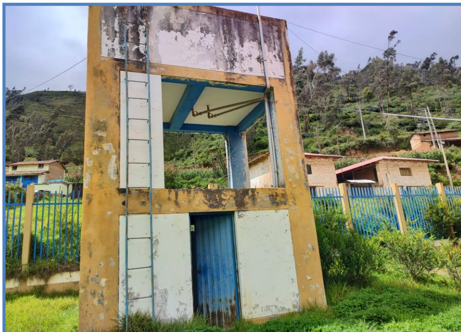
Vista fotográfica: Tanque elevado y tanque cisterna sin mantenimiento . Proyecto: MANTENIMIENTO Y/O REMODELACIÓN DE AMBIENTES ASISTENCIALES DEL CENTRO DE SALUD DE HUARIBAMBA CATEGORÍA I-3 DEL DISTRITO DE HUARIBAMBA – PROVINCIA DE TAYACAJA – REGIÓN HUANCAMELICA.
