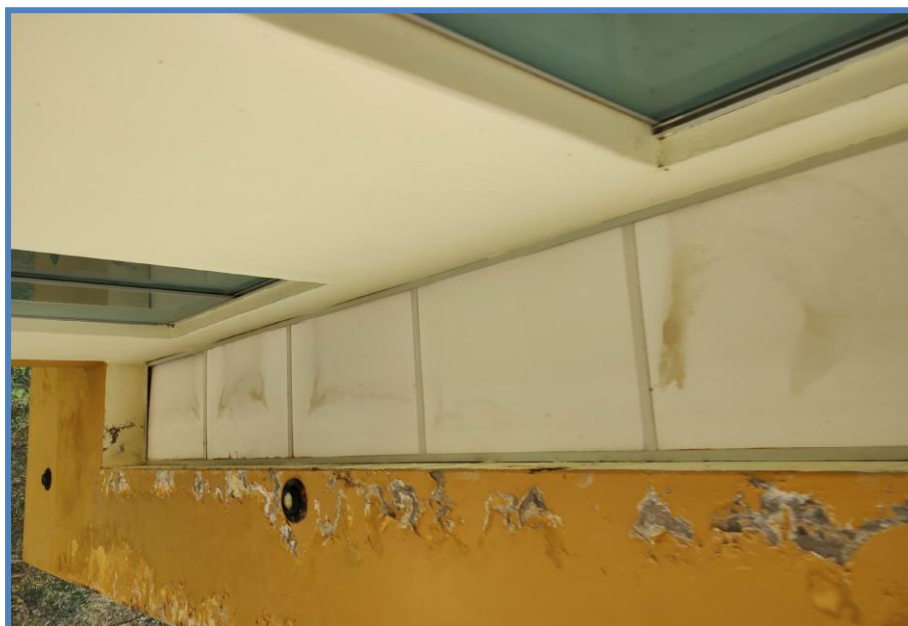
Vista fotográfica: Paredes con la pintura maltratada por filtraciones de agua. Proyecto: MANTENIMIENTO Y/O REMODELACIÓN DE AMBIENTES ASISTENCIALES DEL CENTRO DE SALUD DE HUARIBAMBA CATEGORÍA I-3 DEL DISTRITO DE HUARIBAMBA – PROVINCIA DE TAYACAJA – REGIÓN HUANCAVELICA.
