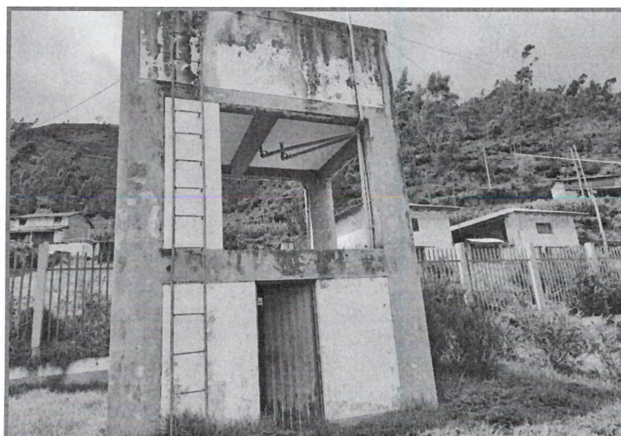
Vista fotográfica: Tanque elevado y tanque cisterna sin mantenimiento . Proyecto: MANTENIMIENTO Y/O REMODELACIÓN DE AMBIENTES ASISTENCIALES DEL CENTRO DE SALUD DE HUARIBAMBA CATEGORÍA I-3 DEL DISTRITO DE HUARIBAMBA – PROVINCIA DE TAYACAJA – REGIÓN HUANCARELICA.
