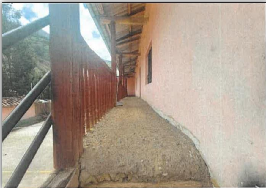
Vista fotográfica N° 07: Se visualiza pasadizo de terreno natural, barandas de madera en mal estado
