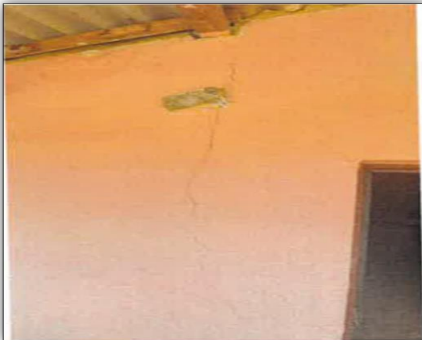
Vista fotográfica N° 03: Se visualiza fisuras en las paredes exteriores
