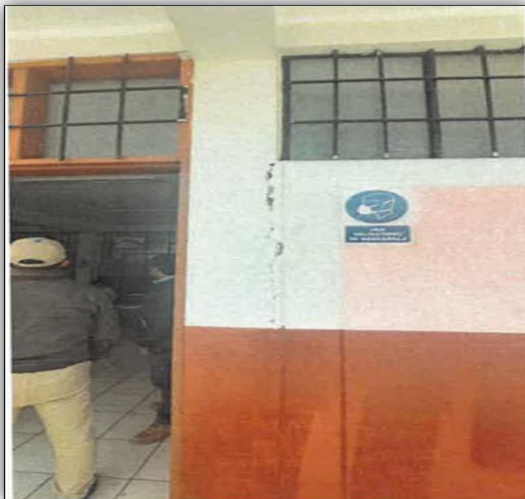
Vista fotográfica N° 09: Vista de fisuraciones
