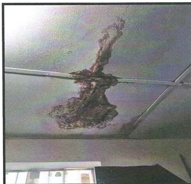
Fotografía N° 02: Vista de humedad en los techos de cielo raso de ambientes.
