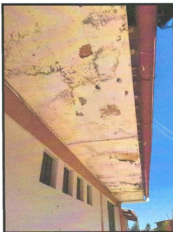
Fotografía N° 04: vista de humedad y deterioro del cielo raso en voladizo.
