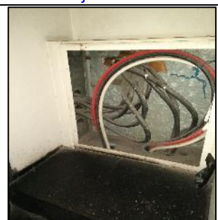
Caja de pase sin tapa protectora
