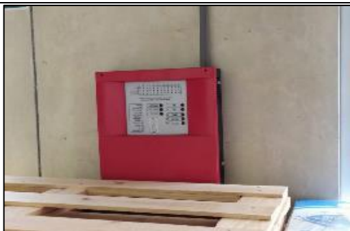
Panel de detección obstruido en almacén
