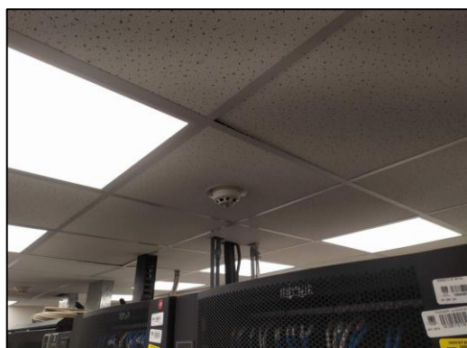
Detector de humo sistema Ecaro-25
