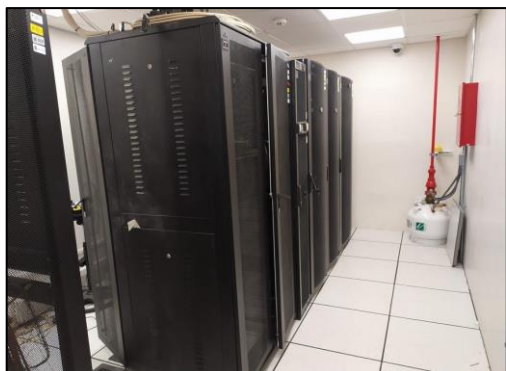
Sala servidores con sistema de extinción
