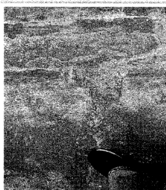
FOTO 22: Vista de piso agrietado y con manchas de ingreso.
