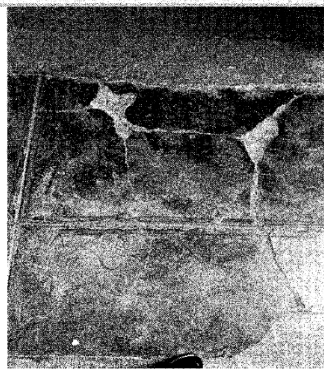
FOTO 23: Vista de tipología de grietas identificadas de 1 a 2.5 cm de profundidad
