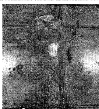
Foto 11: Vista de tipología de grietas identificadas de 1 a 2.5 cm de profundidad
