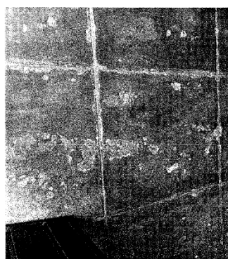
FOTO 13: Vista de piso agrietado y con manchas de ingreso, zona de ingreso
