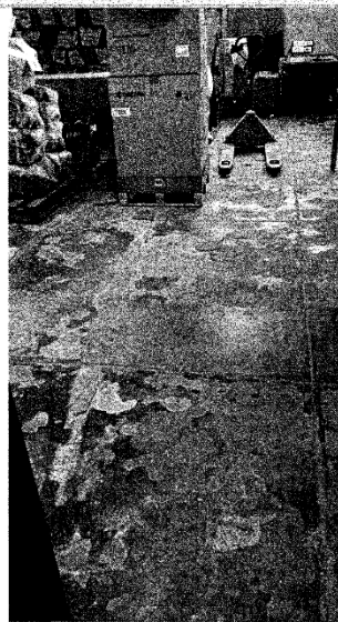
Foto 3: Vista del piso agrietado con descascamiento del concreto
