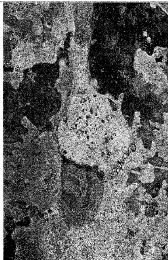
FOTO 5: Vista del estado situacional del piso descascamiento del concreto con grietas de 1.5 cm
