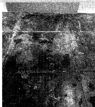
Foto 17: Vista de piso agrietado y con manchas de ingreso, zona central
