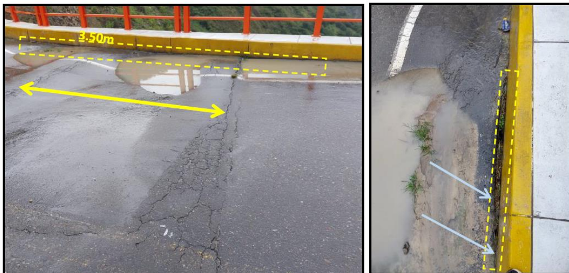
Figura 02. Falla corrugación - grietas
