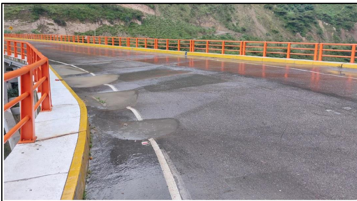
Figura 3. Empozamiento de agua.
