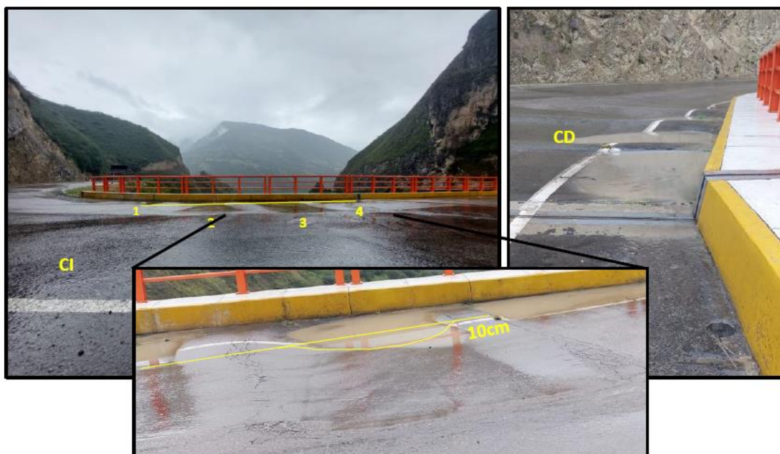
Figura 01. Falla corrugación
