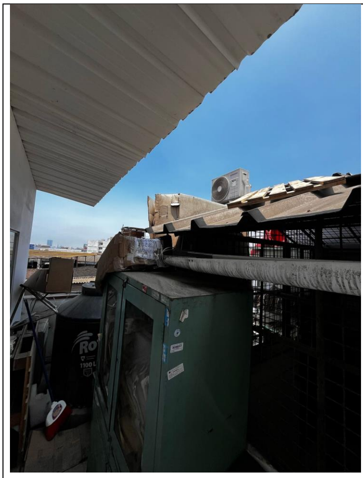
Foto 8. Se observa techos de Aluzinc deteriorados y tanque elevado sin cobertura metálica
