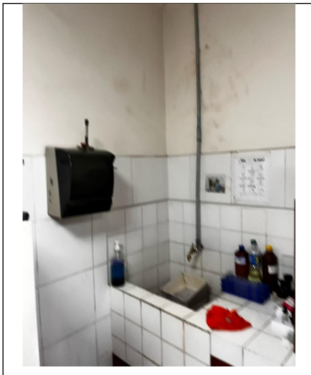
Foto 7. Se observa tuberías de agua de 1/2" expuestas.
