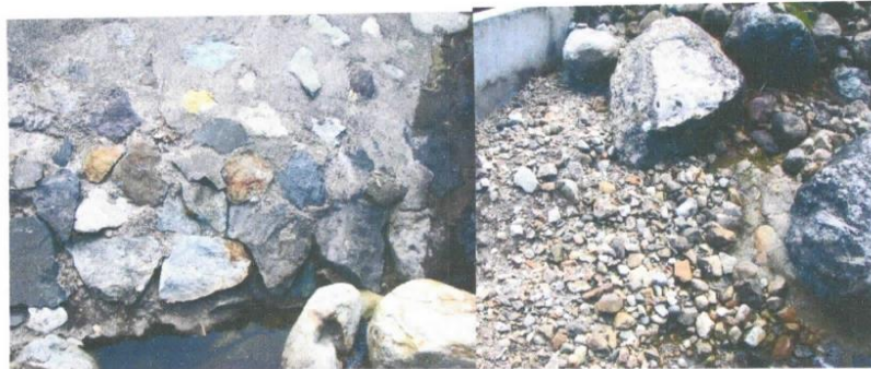
Captación Nahuim Puquio, murso de concreto y piedra y preencia de bolonería, piedras, arena y tierra.
