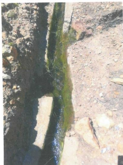
Canal de concreto en malas condiciones presencia de rotura, filtración e inclinación de las paredes
