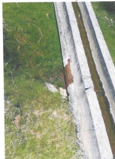
Canal de concreto con daño en la losa y presencia de filtración
