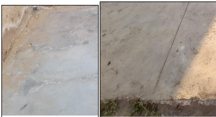
Ilustración 10. Se observa parte de losa de concreto fracturada en los bordes debido al tiempo de antigüedad.
