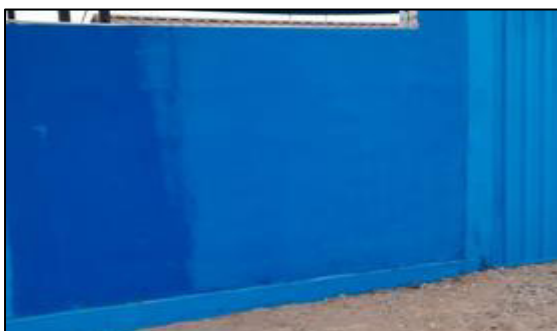
Ilustración 13. Parte del cerco perimétrico de albañilería. Construido sin dirección técnica; no cuenta con vigas de amarre
