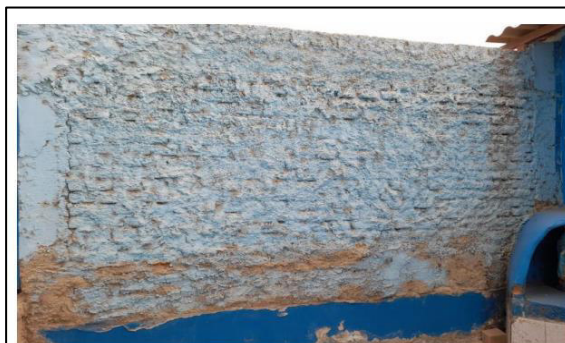
Ilustración 12. Se muestra parte del cerco perimétrico adobe (material precario)
