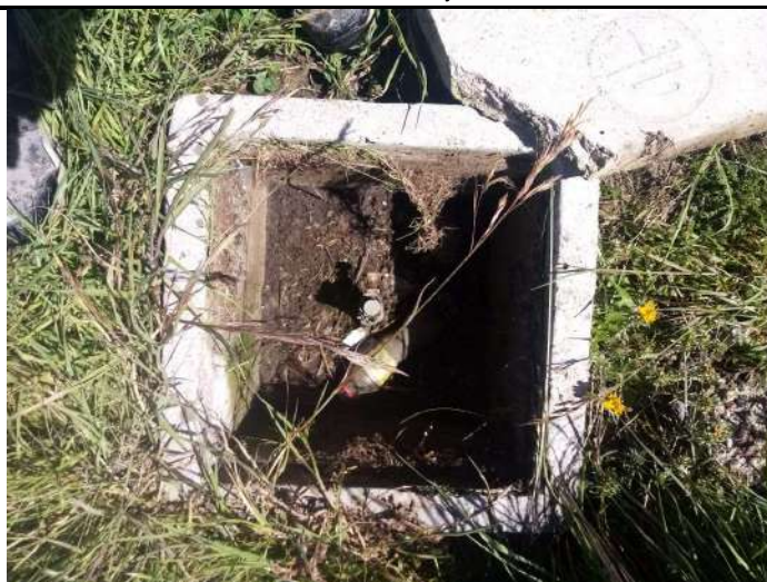
Fig. N° 43 UBICADO EN LA PARTE DERECHA DEL TAMBO, PRESENTA CAJA DE CONCRETO DETERIORADO (pozo a intervenir).
