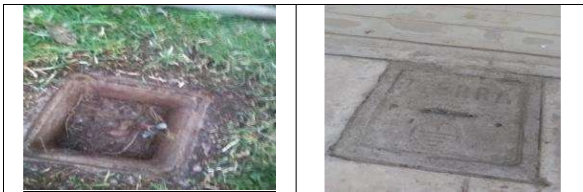
Fig. N° 48 POZOS UBICADOS ALREDEDOR DEL TAMBO, PARA CAMBIO DE CONECTOR, TAPA Y LIMPIEZA.
