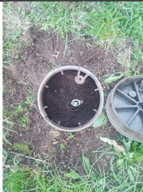
Fig. N° 39 UBICADO EN LA PARTE POSTERIOR, CENTRAL, PRESENTA TAPA DE PLASTICO DETERIORADAD (pozo a intervenir).
