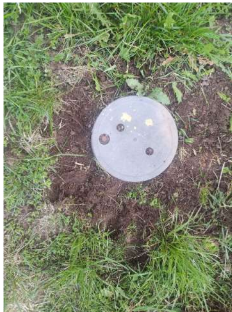
Fig. N° 40 UBICADO EN LA PARTE POSTERIOR, COSTADO DERECHO, TAPA DE PLASTICO DETERIORADA, PARA CAMBIO DE TAPA, CONECTOR Y LIMPIEZA
