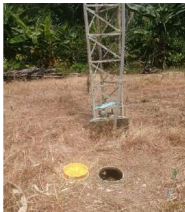
Fig. N° 36 UBICADO A LADO DEL PARARRAYOS. PARA CAMBIO DE CONECTOR
