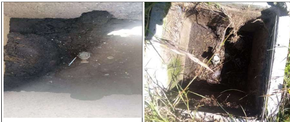
Fig. N° 44 POZOS UBICADOS ALREDEDOR DEL TAMBO, PARA CAMBIO DE CONECTOR, TAPA Y LIMPIEZA.
