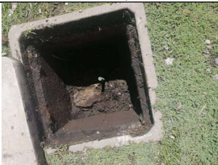
Fig. N° 09 UBICADO EN LA PARTE DE ADELANTERA, COSTADO IZQUIERDO, PRESENTA CAJA DE CONCENTRO SIN PINTAR (CABE MENCIONAR QUE NO TIENE CONECCION A LA INFRAESTRUCTURA DEL TAMBO). (pozo a intervenir)
