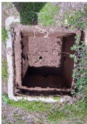
Fig. N° 38 UBICADO EN LA PARTE DELANTERA LADO DERECHA, TAPA DE CEMENTO EN ESTADO REGULARA. (pozo a intervenir).
