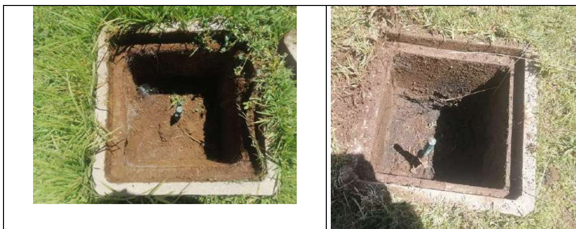
Fig. N° 28 POZOS UBICADOS ALREDEDOR DEL TAMBO, PARA CAMBIO DE CONECTOR, TAPA Y LIMPIEZA.
