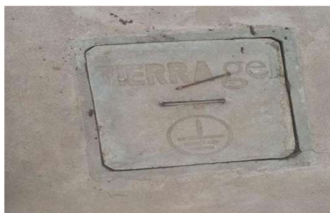
Fig. N° 24 POZO UBICADO ALREDEDOR DEL TAMBO, PARA EL CAMBIO DE CONECTOR
