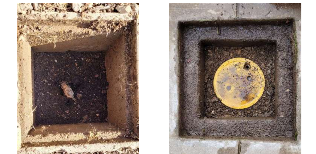
Fig. N° 19 POZOS UBICADOS ALREDEDOR DEL TAMBO, PARA EL CAMBIO DE CONECTOR Y TAPA
