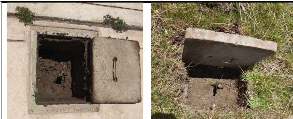
Fig. N° 52 POZOS UBICADOS ALREDEDOR DEL TAMBO, PARA CAMBIO DE CONECTOR, TAPA Y LIMPIEZA.
