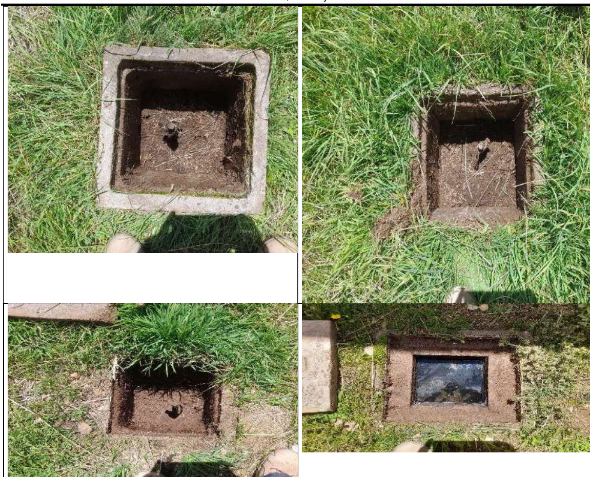
Fig. N° 30 POZOS UBICADOS ALREDEDOR DEL TAMBO, PARA CAMBIO DE CONECTOR, TAPA Y LIMPIEZA.
