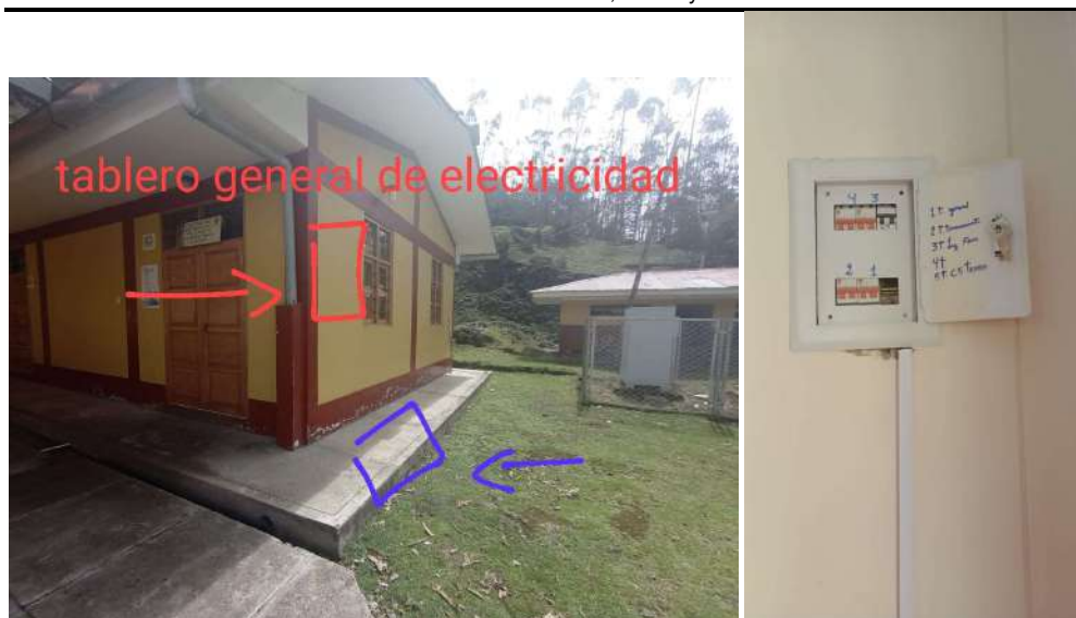
Fig. N° 20 UBICACIÓN DEL TABLERO ELECTRICO, DONDE DEBE LLEGAR LA CONEXIÓN DEL POZO A TIERRA.
