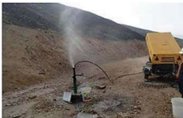
Figura 1: Expulsión de agua con aire comprimido
