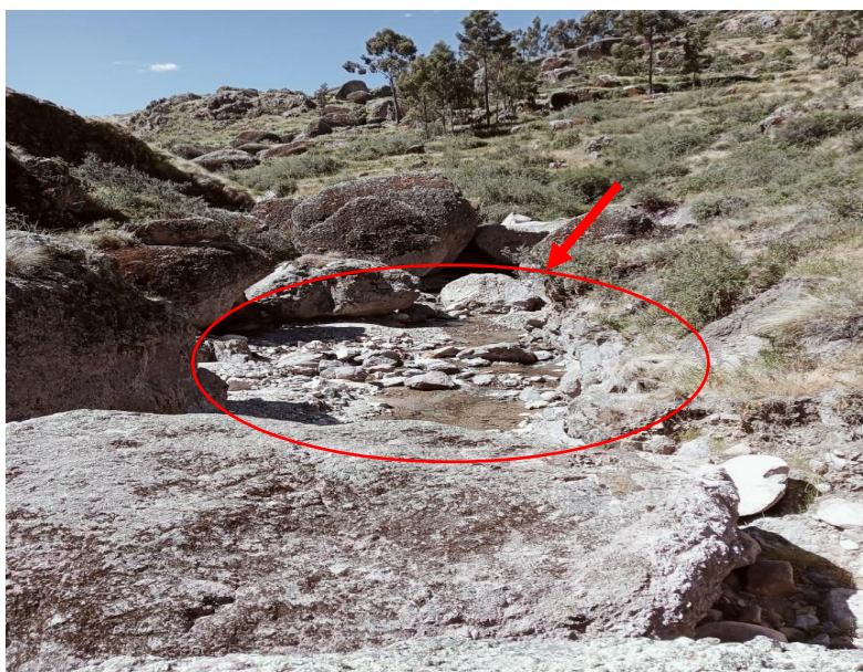
Foto N° 02.- Inexistencia de obra de arte, hace intransitable la vía en épocas de lluvia
