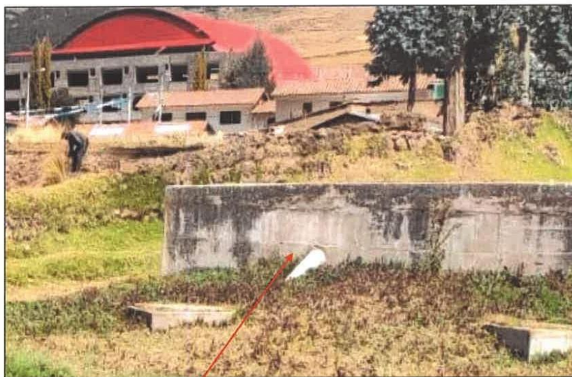
Tubería expuesta a la salida del tanque séptico de doble cámara.
