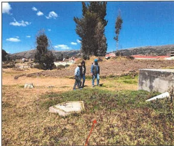
Zanjas de percolación existentes, las cuales se encuentran saturadas a causa de la colmatación y falta de cambio de filtros.
