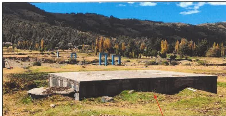
Tanque séptico con dos cámaras en paralelo
