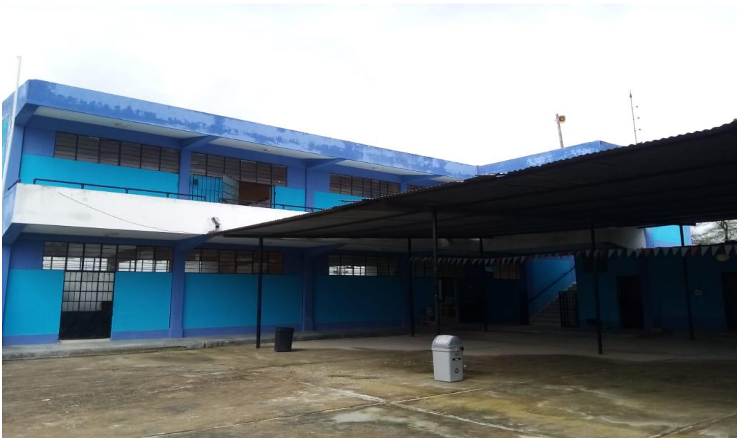
IMAGEN N° 03: El bloque N° 01, el cual es de 2 pisos, está conformado por 06 aulas, de las cuales una de estas es usada como Dirección, el cual tiene más de 20 años de antigüedad, cumpliendo ya con su vida útil está construido de material noble, bajo el sistema constructivo de muros portantes, confinados con columnas y vigas, el techo es de cobertura losa aligerada, el piso es de loseta y una vereda en el frontis de cemento pulido en mal estado de conservación.
