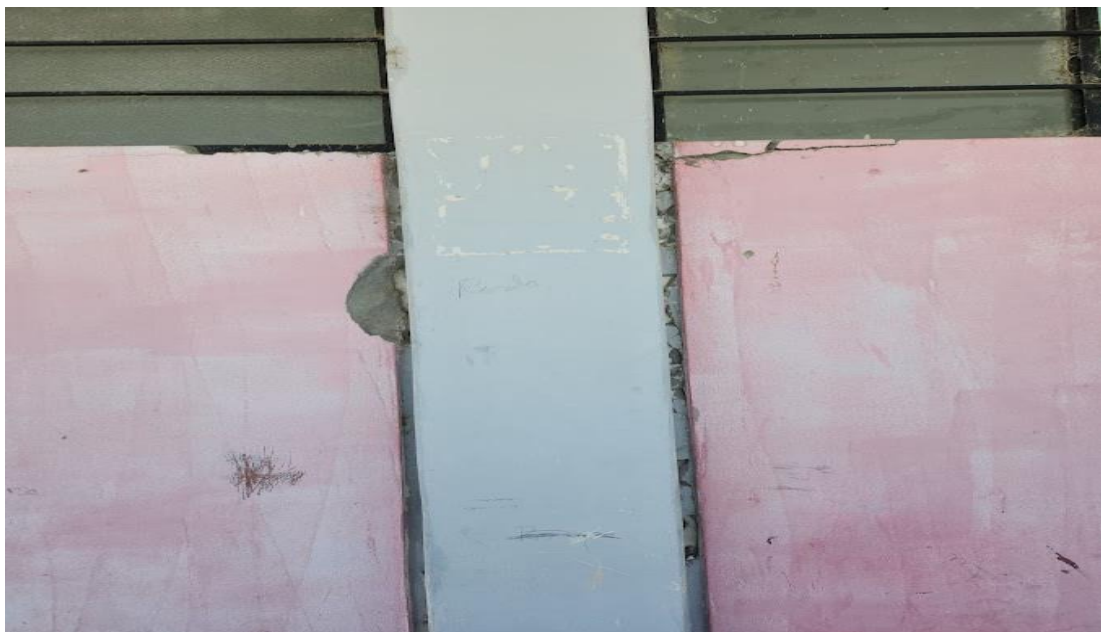
IMAGEN N° 05: se aprecia la junta de dilatación en muros portantes, la cual notoriamente se encuentra en mal estado, no cuenta con el sello asphaltico, solo se aprecia en su largo que ha sido rellenada de Tecnopor, el cual está desgastado y representa un peligro ante un evento sísmico, ya que aquí se puede producir efecto de columna corta al quedar restringido el desplazamiento lateral de esta.
