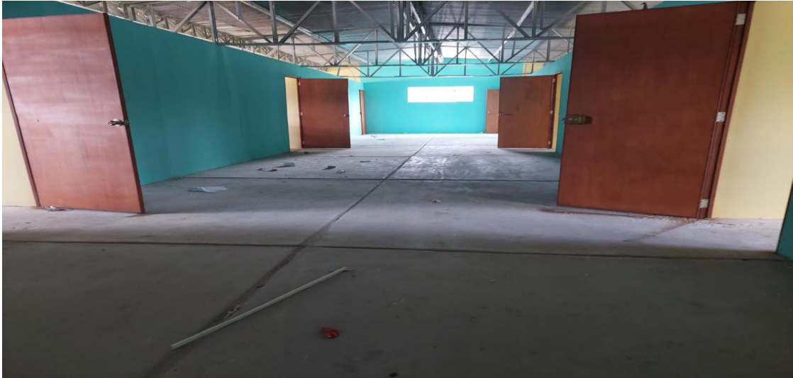
IMAGEN N° 02: las aulas son construidas de material precario de triplay, no teniendo las condiciones mínimas adecuadas para ambientes de educación inicial. No presentan seguridad, asimismo, debido a la naturaleza de estas hace que se de calor excesivo dentro de estas.
