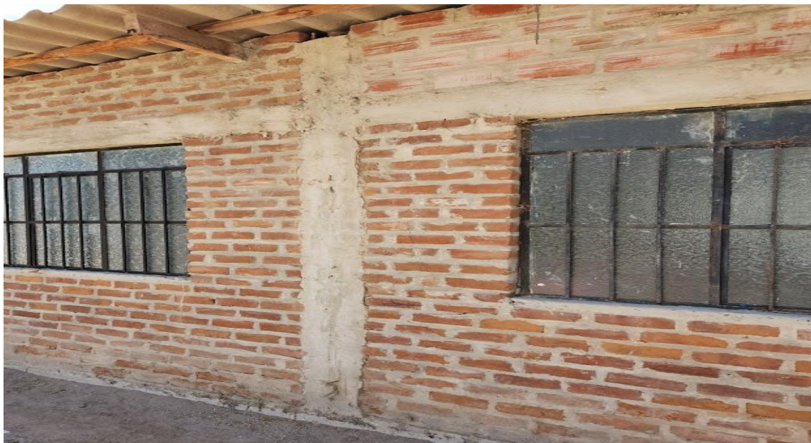
IMAGEN N° 12: se puede apreciar que no se ha tenido criterio técnico alguno para la construcción de esta edificación, los bloques de ladrillo están desalineados, las columnas presentan cangrejas, se pudo corroborar que el mortero se desprende con facilidad.
