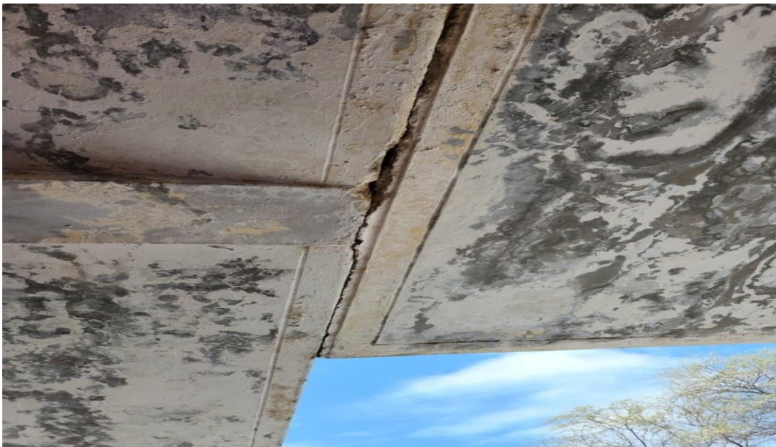
IMAGEN N° 07: en la estructura del techo del segundo nivel del pabellón educativo se puede apreciar fisuramientos en las partes que comprende el balcón y las aulas. Esta parte funciona como junta de dilatación, pero se pudo ver que no durante el proceso constructivo no se le ha colocado relleno asfáltico.
