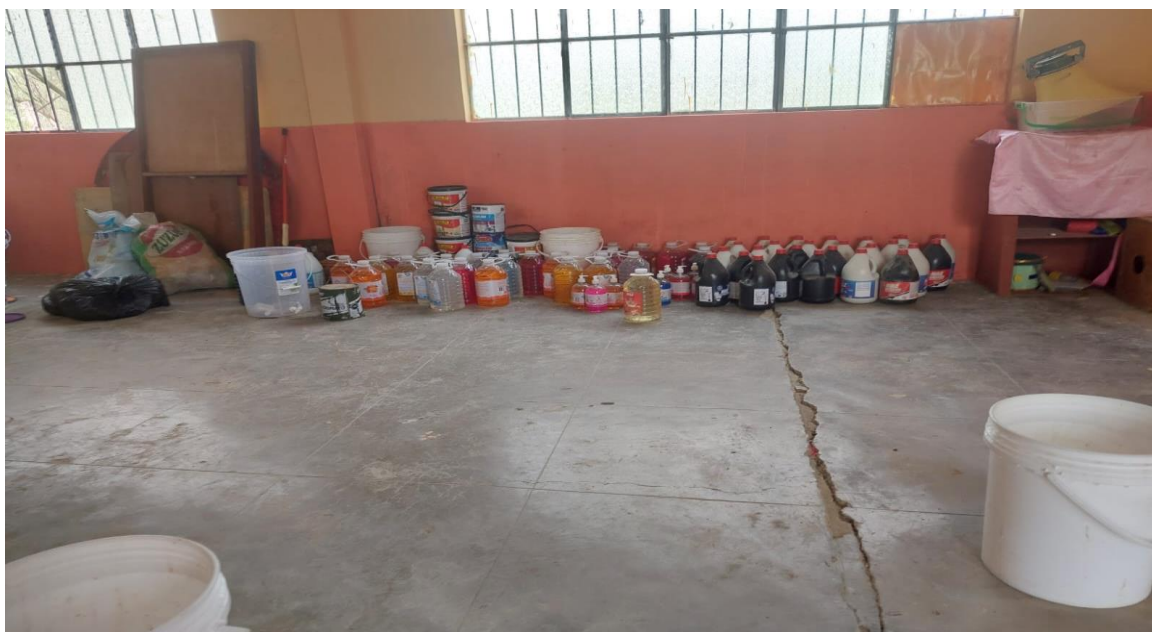
IMAGEN N° 13: el piso de los ambientes es de cemento pulido, el cual se encuentra en mal estado de conservación, presentando grandes agrietamientos como se muestra en la imagen.
