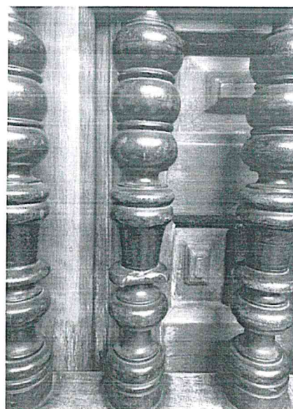
ELEMENTOS DAÑADOS POR IMPACTOS
