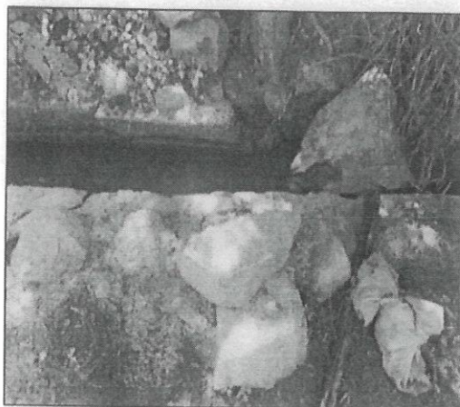
FOTO N°04: Tubería HDPE en mal estado.
