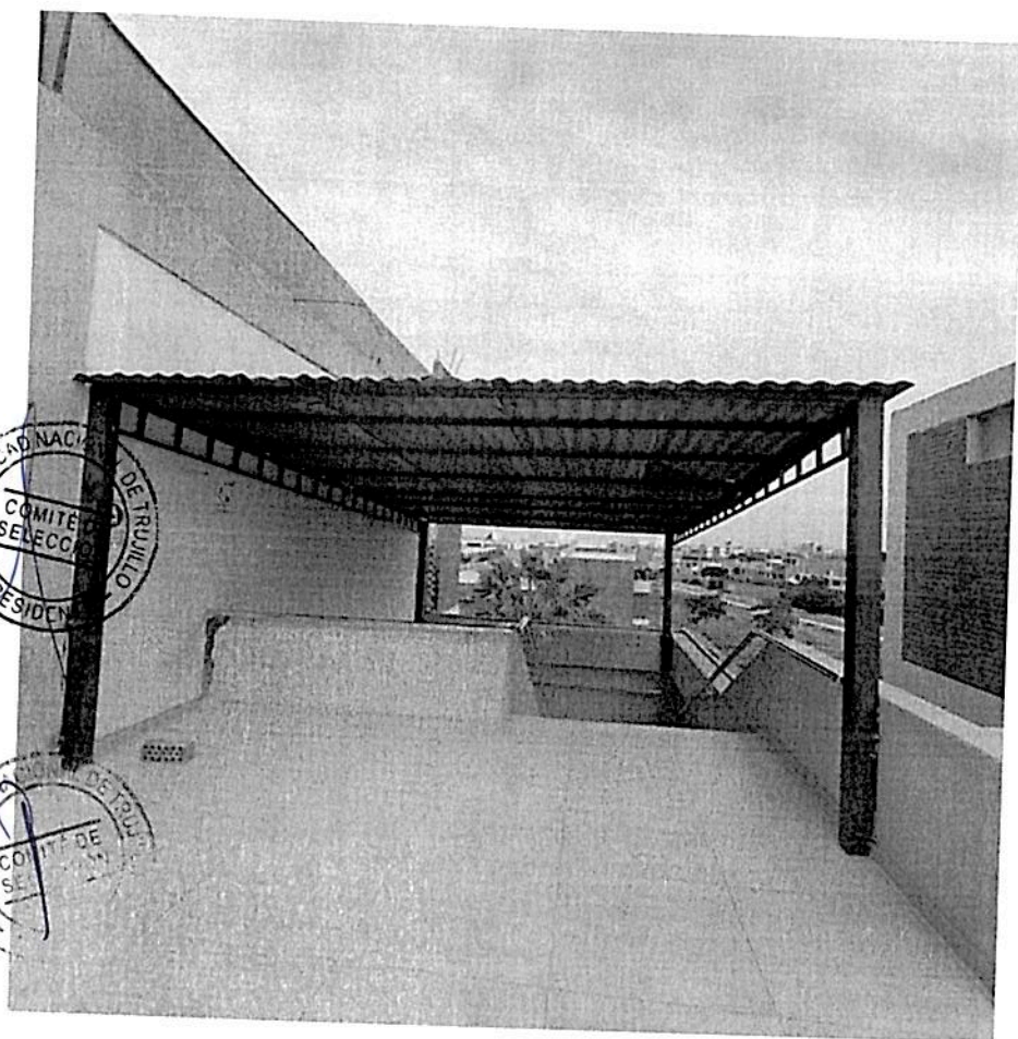
Estructura metálica oxidada, y cubierta en mal estado
