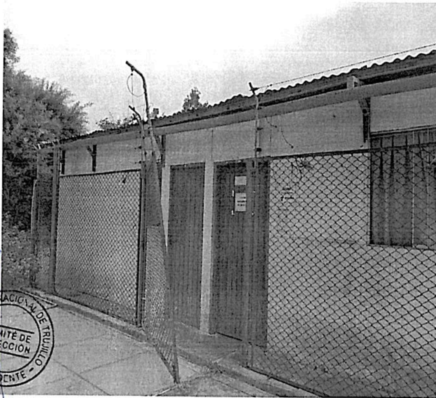
Cerco perimétrico, dañado, oxidado
