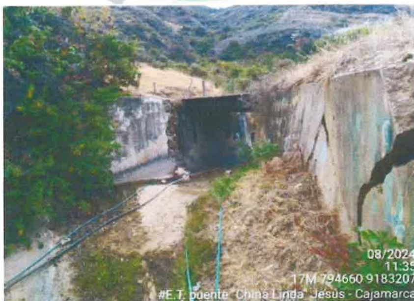
Fotografía N°5: Vista de aleta del puente fracturada lado izquierdo aguas abajo
