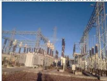
Fig. 23. Transformador de 50 MVA, 220/66/10kV de la SET Mollepata.
