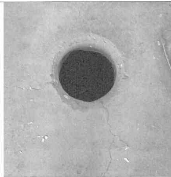
SUMIDERO DE BRONCE PESADO 6", INC/RELLENO CON MORTERO ARMADO
