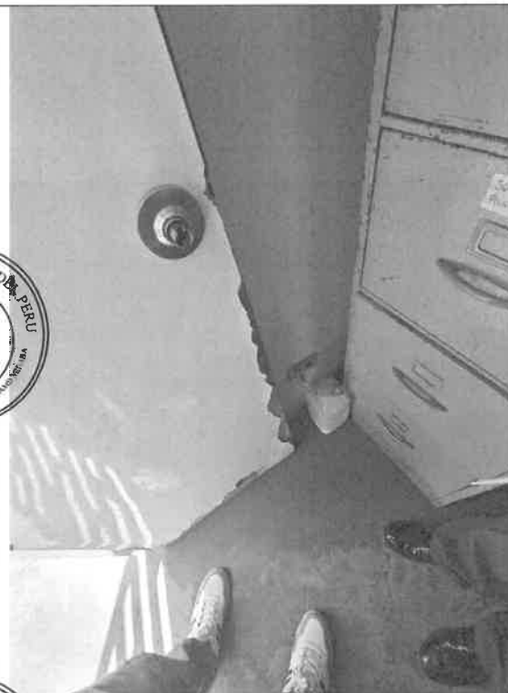
CAMBIO DE PUERTA CONTRAPLACADA CON FORMICA BLANCA AMBOS LADOS DE PUERTA 0.70 x 2.45m INC/MARCO DE MADERA, VIDRIO DE 4mm C/LAMINA DE SEGURIDAD, CERRADURA TIPO PERILLA
