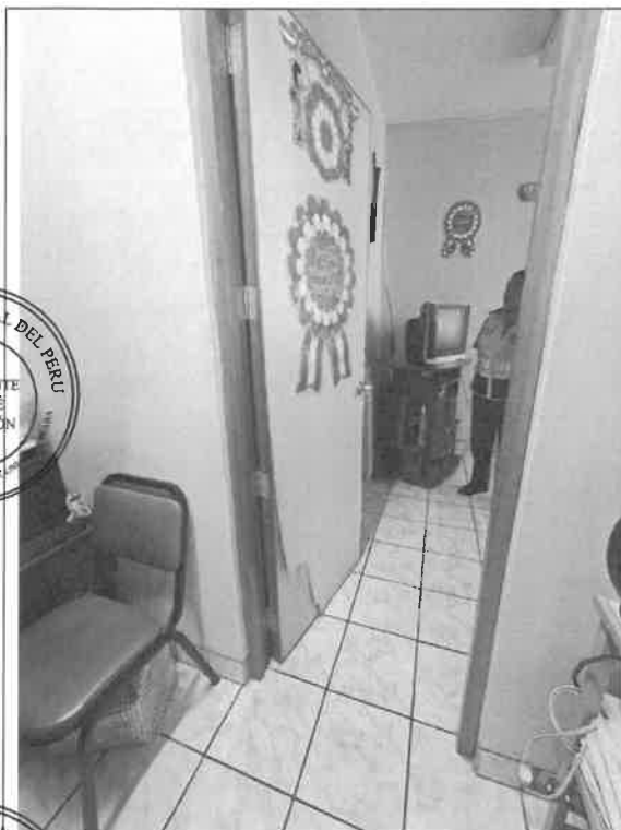
CAMBIO DE FORMICA BLANCA EN CARA DE PUERTA 0.72 x 2.10m
