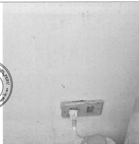
CAMBIO DE TOMACORRIENTE DOBLE L/T
