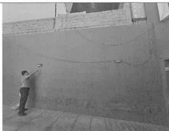
CAMBIO DE LUMINARIA APLIQUE EXTERIOR TORTUGA - IP65
