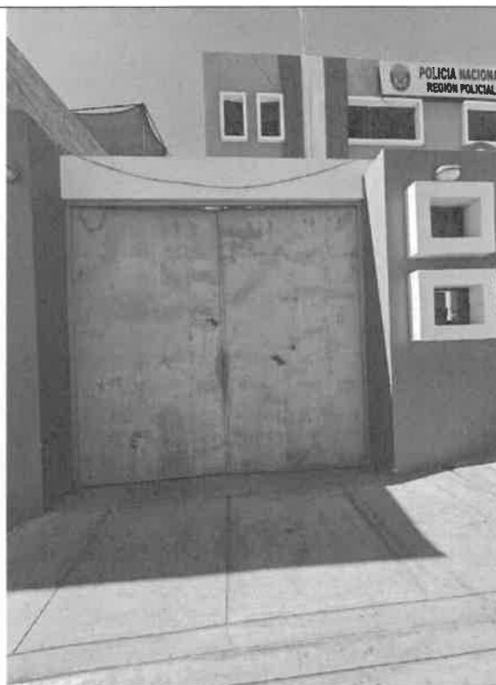
LIMPIEZA MECANICA, LIJADO, PINTADO DE PORTON METALICO
