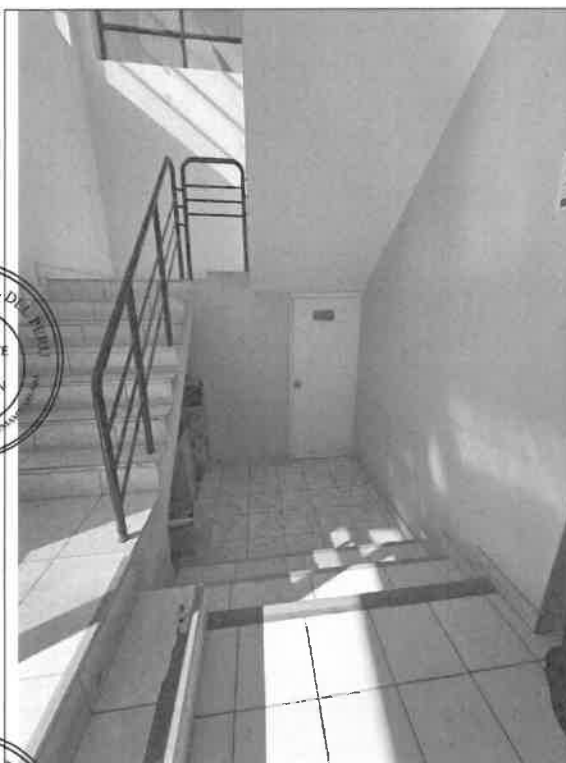
COLOCACION DE CINTA ANTIDESLIZANTE EN PASOS Y DESCANSO
