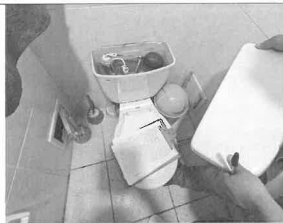
CAMBIO DE VALVULA C/PALANCA PARA INODORO
