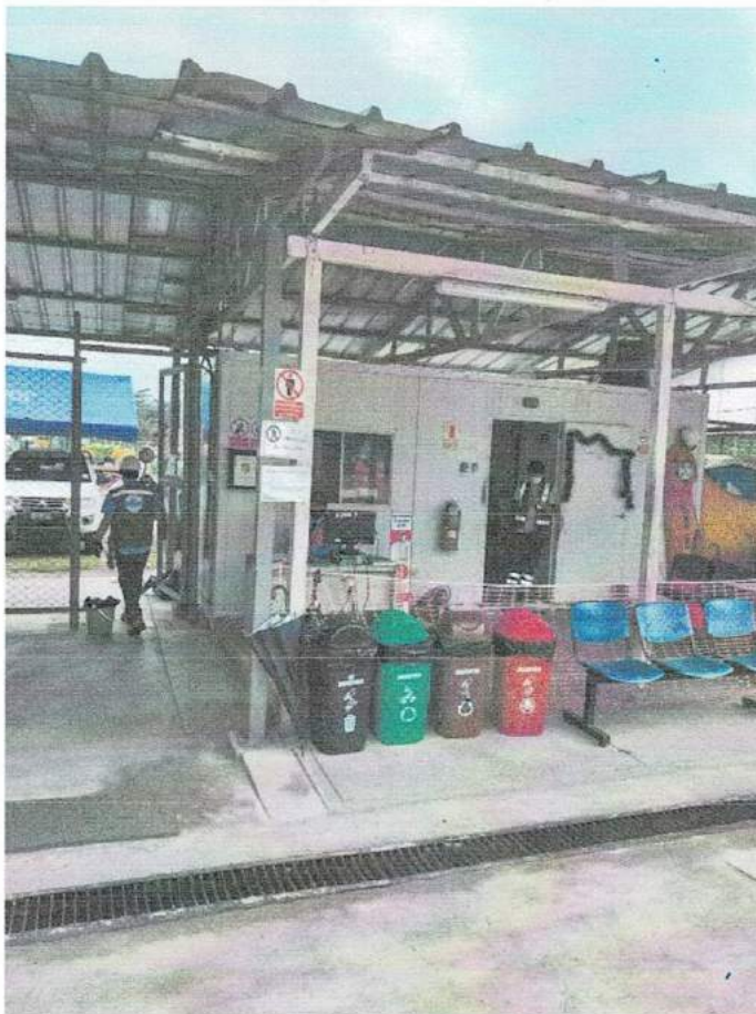
Alcantarilla de 0.30x0.30, delante de caseta de control sunat, muy pequeño.
