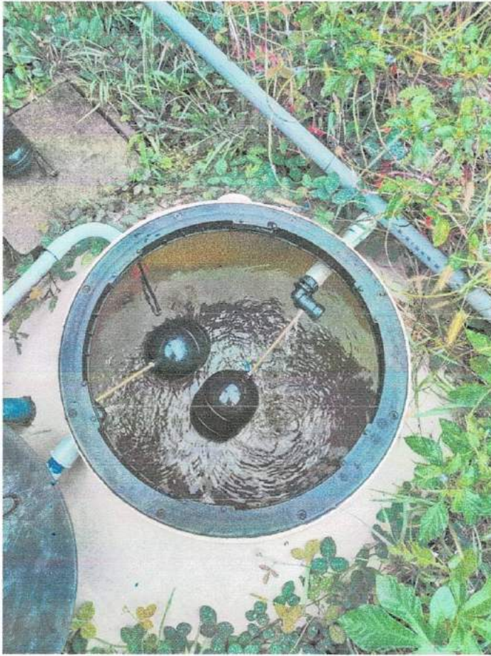
Tanque Rotoplas con sedimentos
