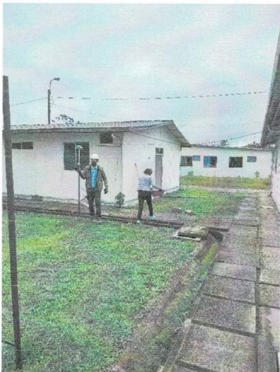
SISTEMA DE DRENAJE JUNTO A MODULOS Y ALEROS DE 50 CM
