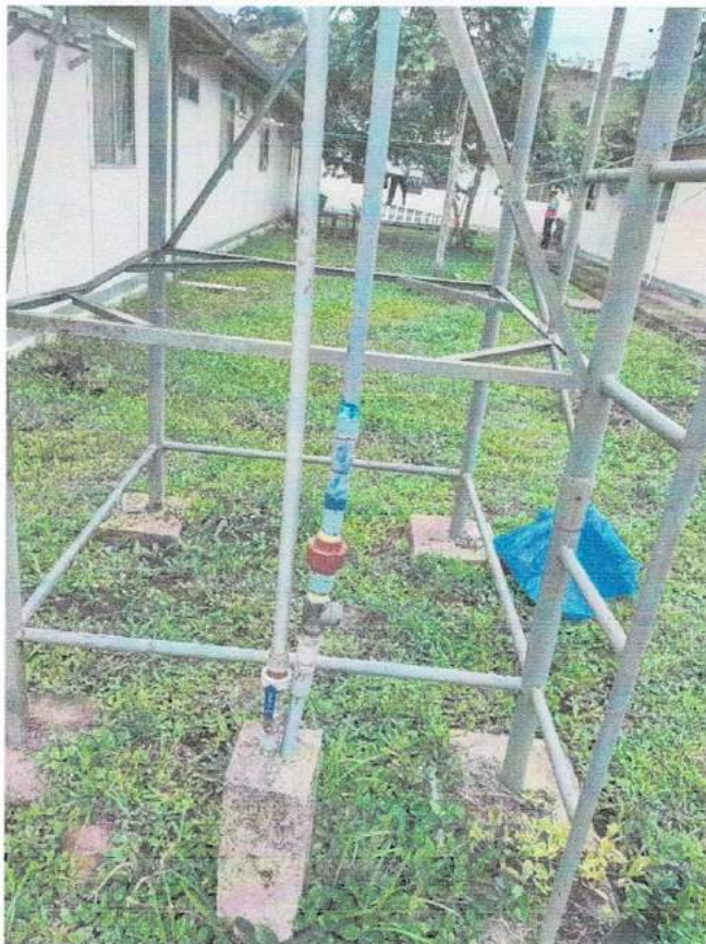
Valvulas que suben a tanque elevado
