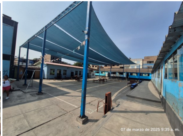
Imagen N°03: Vista lateral del Patio de nivel primaria de losa concreto de buen estado, para intervenir con cobertura de malla raschell con estructura metálica según diseño. Se realiza la intervención en los anclajes y en la base y pedestal del concreto ya tiende a colapsar.
