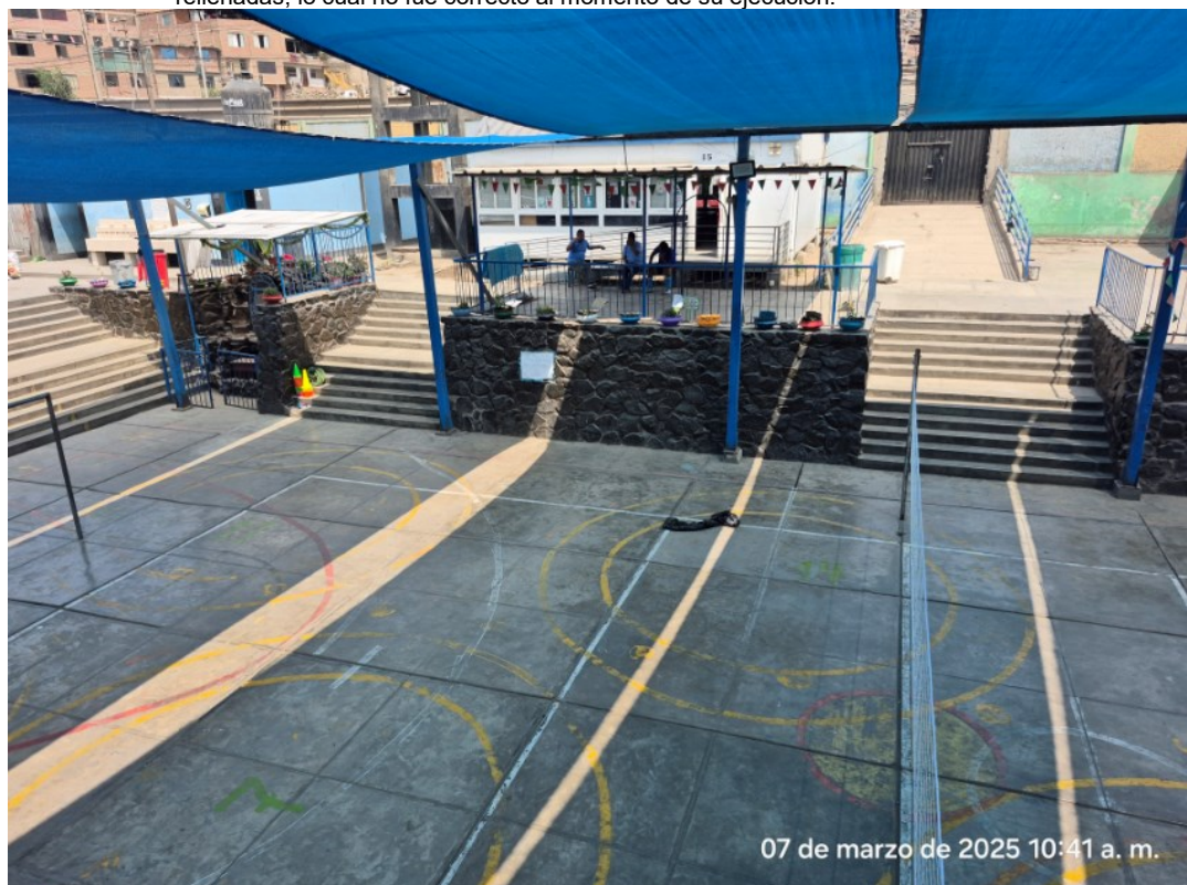
Imagen N°06: Vista desde la parte superior del patio nivel Secundaria, se verifica que las columnas metalicas de la estructura metalica se encuentran inclinadas por su propio peso y del concreto que han sido rellenas, lo cual no fue correcto al momento de su ejecucion.
