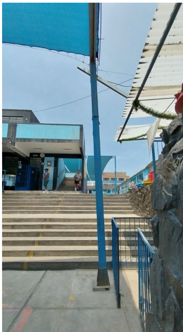
Imagen N°08: En el patio del nivel secundaria se muestra columnas inclinadas debido a su propio peso y al vaciado de concreto dentro de ellas de manera irregular, poniendo en peligro a los educandos.
