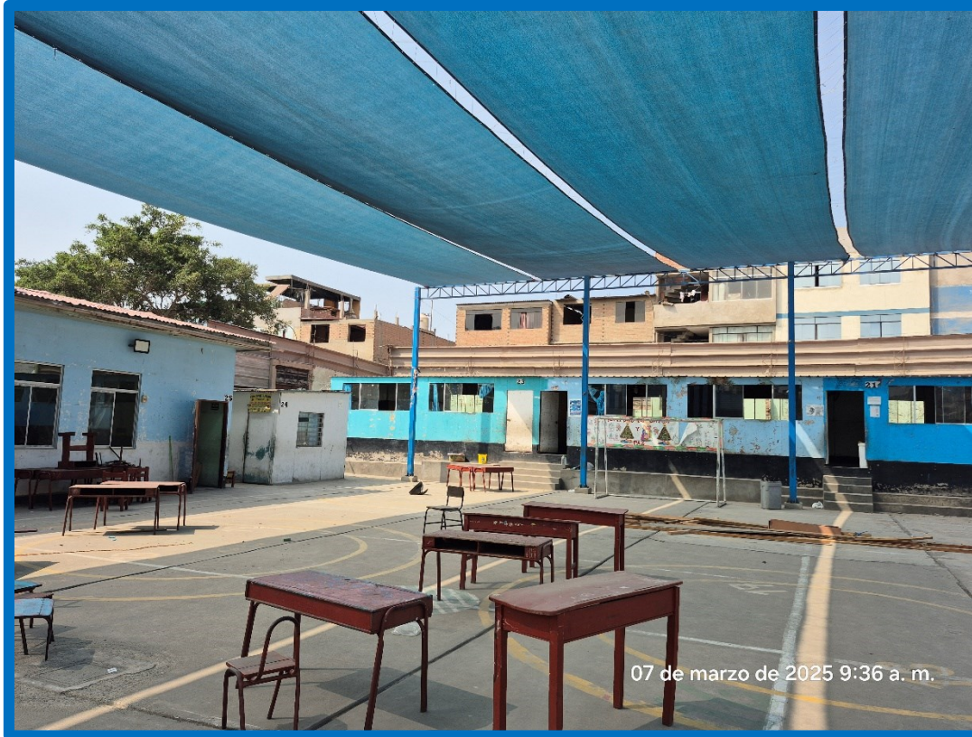
LA COBERTURA DE MALLMA RASCHEL SE ENCUENTRA DETERIORADA
