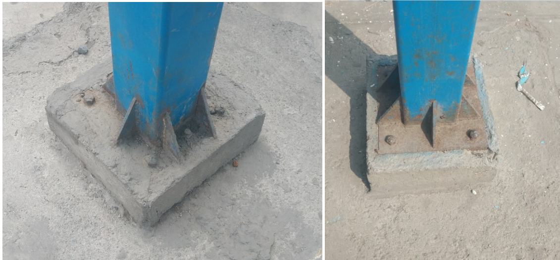
Imagen N°04: En el patio de primaria, las columnas existentes de 6"x6" muestran un deterioro debido al óxido que se ha impregnado en la plancha de anclaje. De igual manera en el elemento de concreto que se encuentra fisurado, lo que podría ocasionar un posible colapso de la estructura metálica que lo conforme. Conforme a lo coordinado por los especialistas de la UGM, esta situación amerita que esta priorización se encuentre dentro de las metas del Exp. Técnico de Acondicionamiento.
