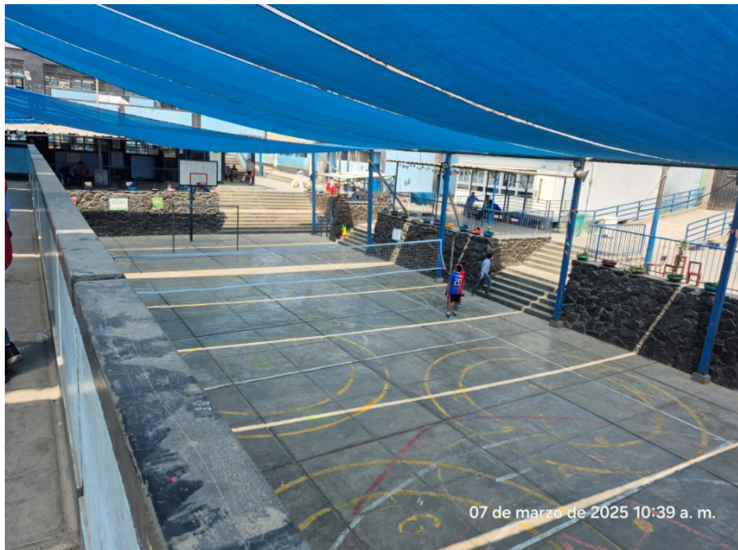
Imagen N°05: Vista desde la parte superior del patio nivel Secundaria, se verifica que las columnas metalicas de la estructura metalica se encuentran inclinadas por su propio peso y del concreto que han sido rellenas, lo cual no fue correcto al momento de su ejecucion.
