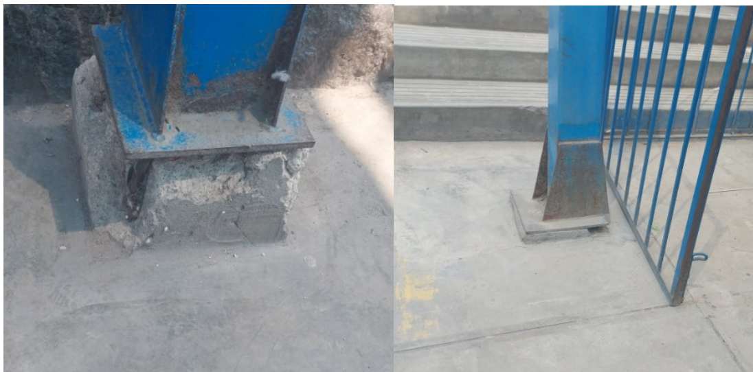
Imagen N°07: En los anclajes del patio de secundaria muestran un gran deterioro que ponen en peligro a la estructura metálica que conforma la cubierta.
