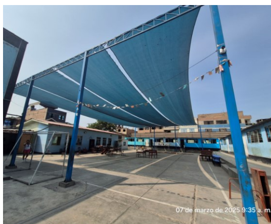
Imagen N°03: Vista lateral del Patio de nivel primaria de losa concreto de buen estado, para intervenir con cobertura de malla raschell con estructura metálica según diseño. Se realiza la intervención en los anclajes y en la base y pedestal del concreto ya tiende a colapsar.
