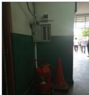
VISTA 03: ÁREA DE RECEPCIÓN Y CORREDOR DONDE SE UBICA EL TABLERO GENERAL DEL EDIFICIO A NPT m+1.40m. ES UN GABINETE GALVANIZADO DE 25X50 CON LLAVES TERMOMAGNÉTICAS EN ESTADO REGULAR DE CONSERVACIÓN. CABLES TOTALMENTE EXPUSTOS.
