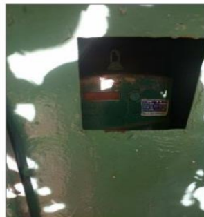
VISTA 01: MEDIDOR DE ENERGÍA ELÉCTRICA MONOFÁSICO UBICADO EN PARAPÉ DE MURO EXTERIOR LADO DERECHO, LUGAR DEL ÁREA VERDE, DETRÁS DE UN ÁRBOL.
