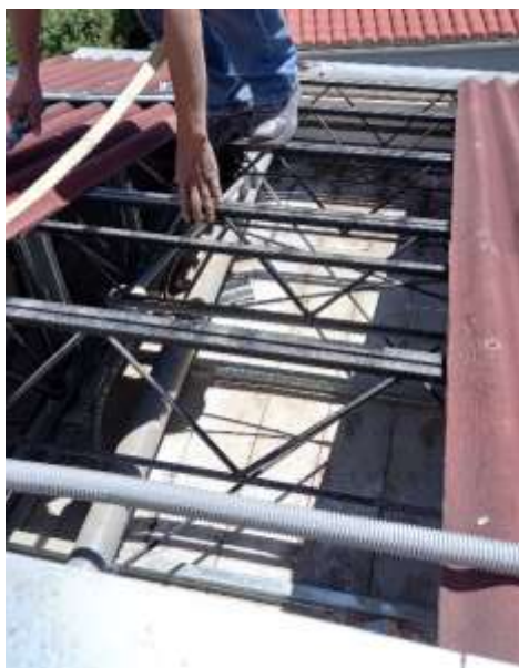
Imagen N° 31: Parte de la estructura metálica de los aleros en la azotea.
