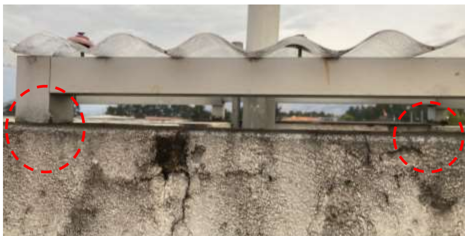
Imagen N° 21: Parte de la estructura de la cobertura, algunas piezas requieren cambio por estar deterioradas.
