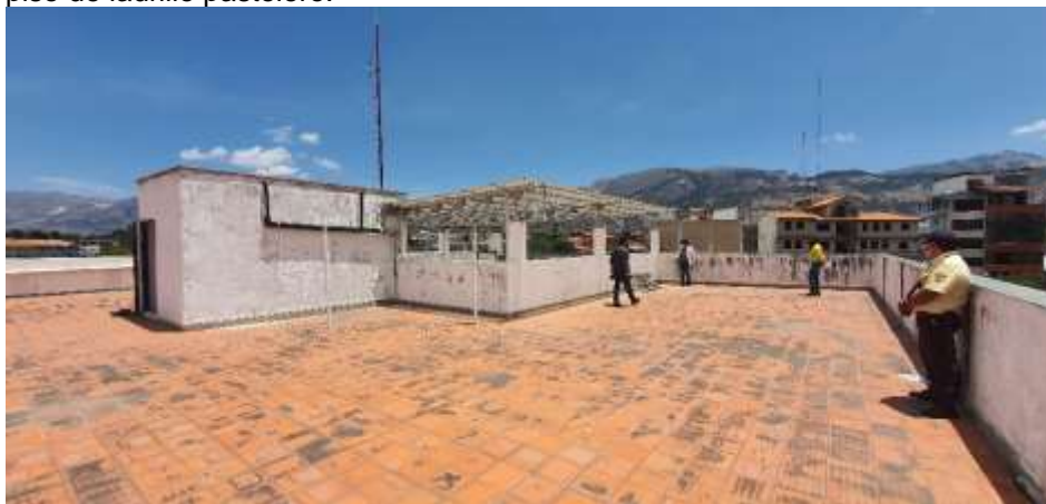
Imagen N° 36: Parte del piso de ladrillo pastelero en la azotea.
