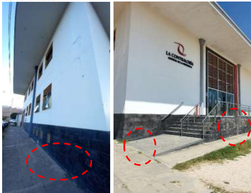
Imágenes N° 04 y 05: Parte de la junta de construcción en el primer piso (muro con enchape rústico y piso de adoquines) encuentro con la vereda pública.
