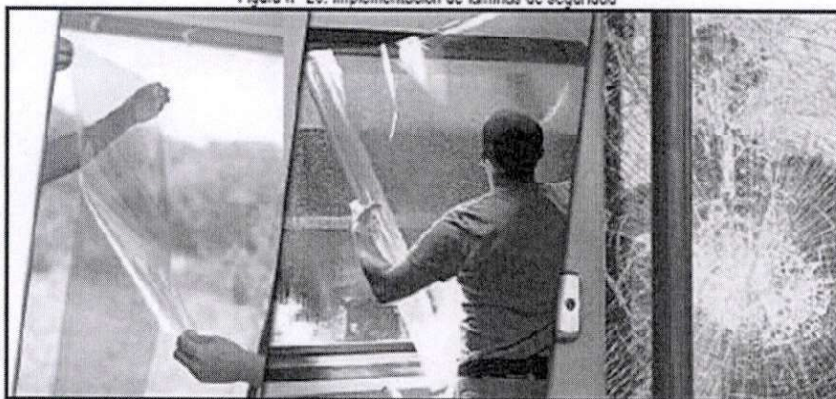
Figura n° 26: Implementación de láminas de seguridad
