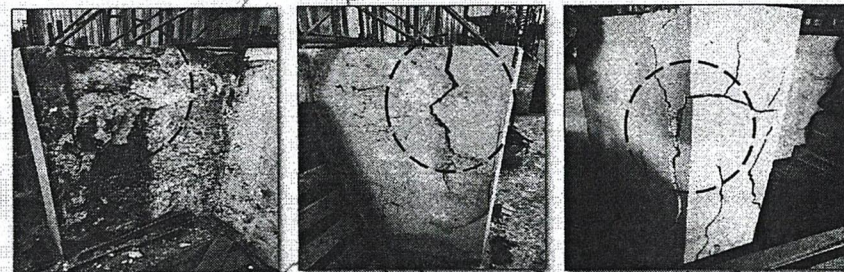
VISTA PRELIMINAR DE LAS COLUMNAS. SE APRECIA EL DETERIORO DEL CONCRETO Y LOS ACEROS
