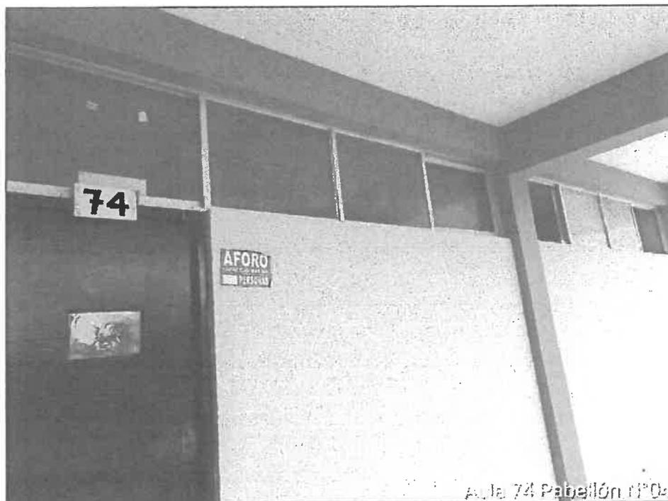
Figura 156. Laminado de 4 micras en ventanas y mantenimiento de ventanas incl. marcos y accesorios en aula 74 del B-04.
