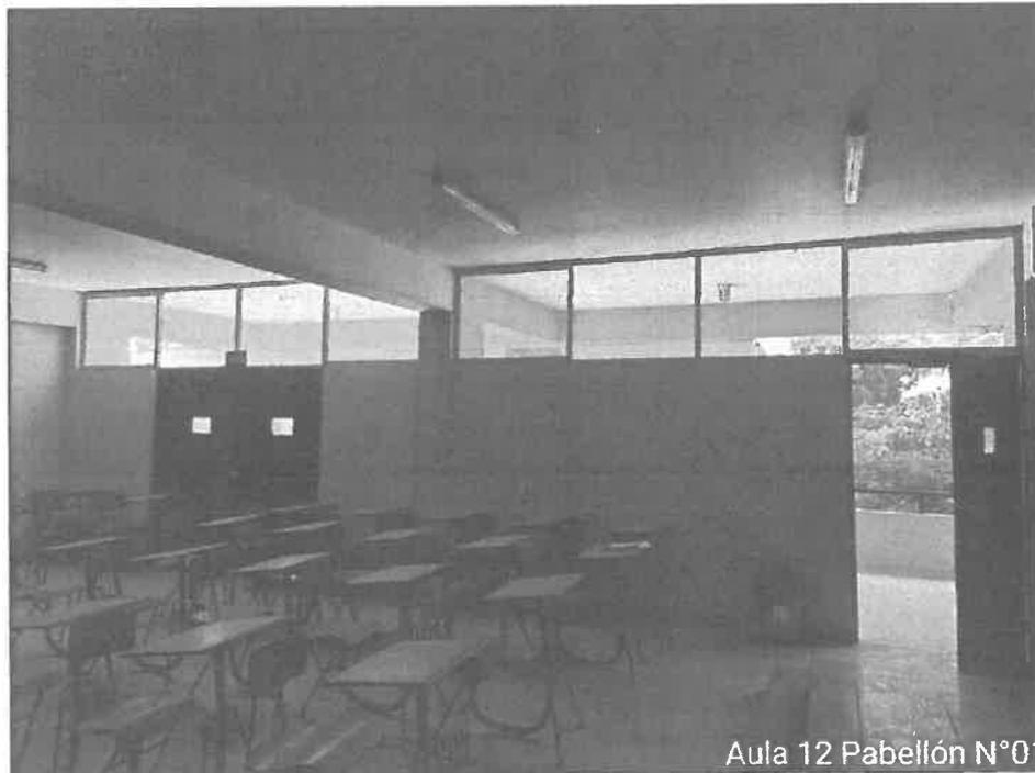
Figura 35. Instalación de vidrio crudo e=6mm, laminado de 4 micras en ventanas y mantenimiento de ventanas incl. marcos y accesorios en aula 12 del B-01.
