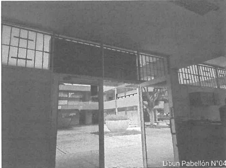
Figura 112. Instalar vidrio crudo  $e=6\text{mm}$ , laminado de 4 micras en ventanas y mantenimiento de ventanas incl. marcos y accesorios en librería universitaria del B-04.
