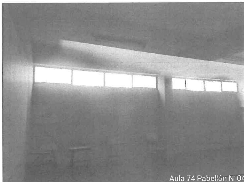
Figura 157. Laminado de 4 micras en ventanas y mantenimiento de ventanas incl. marcos y accesorios en aula 74 del B-04.
