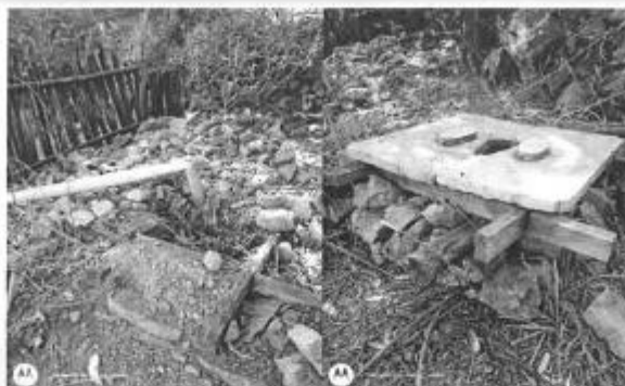
Letrinas de hoyo seco en pésimas condiciones en la localidad de Cuije
