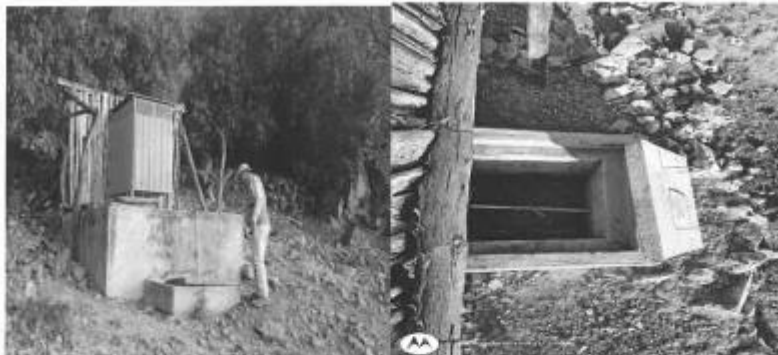
Reservorio de la comunidad de Socos. Cerco de la válvula de caseta cercos inadecuados, muros con rajaduras instalaciones inadecuados.
