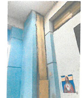
AUSENCIA DE TAPAJUNTAS O SE ENCUENTRAN EN MAL ESTADO
