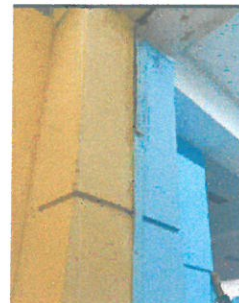
FILTRACION EN JUNTAS DE DILATACION
