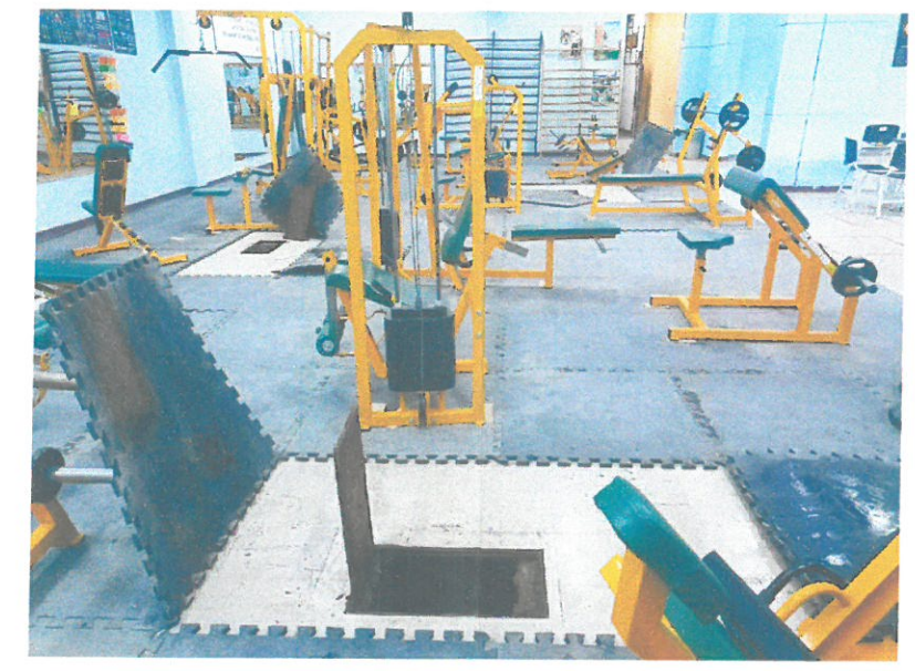
SE OBSERVA LOS BUZONES EN MAL ESTADO Y CON DIFERENTES RESIDUOS EN SU INTERIOR.
