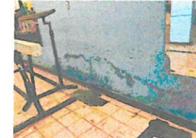
PINTURA DESPRENDIDA POR HUMEDAD
