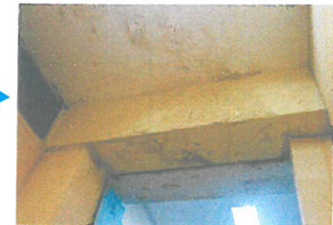
PINTURA EN MAL ESTADO DEBIDO A FILTRACIONES
