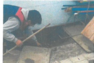
CAJA DE REGISTRO SIN TAPA NI PROTECCION ADECUADA
