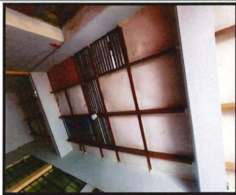
Fotografía N°05: cobertura liviana afectado por precipitaciones pluviales que han generado deterior y oxido.
