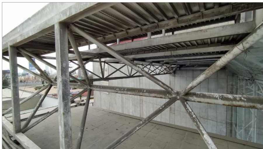
ESTRUCTURA METÁLICA: TIJERALES, PLACA COLABORANTE
