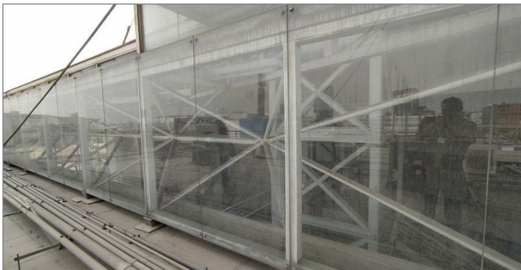
FACHADA SUPERIOR DERECHA HALL PRINCIPAL SUJECIÓN DE VIDRIO CON PERNOS
