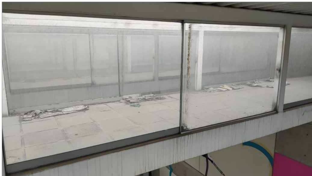
VISTA DE VENTANA CORREDIZA TÍPICA A DESMONTAR
