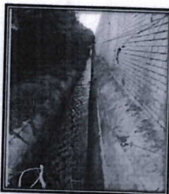
Imagen N° 04: En la figura se muestra el canal de conducción Mejorada, y con el proyecto se revestirá con concreto
