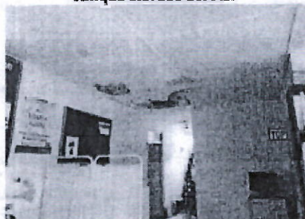
Goteras en el cielo raso del tópico en el P.S.
