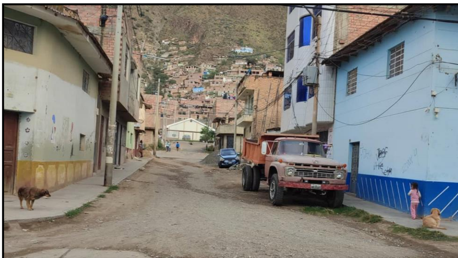
Foto N° 03: Vista del Jr. Norberto Aro Cuadra 2 carente de pistas, cunetas y presenta baches que dificultad el tránsito vehicular y cuenta con veredas en ambos lados
