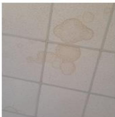
Panel fotografico de la necesidad del cambio de baldosas deterioradas por goteras
