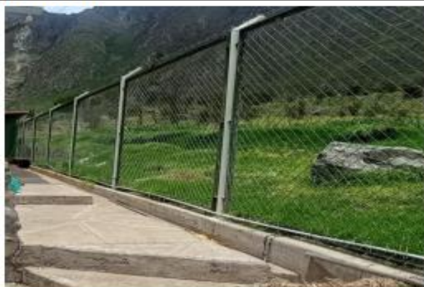
Panel fotográfico de la necesidad del repintado de paneles, postes y zócalos del cerco perimétrico
