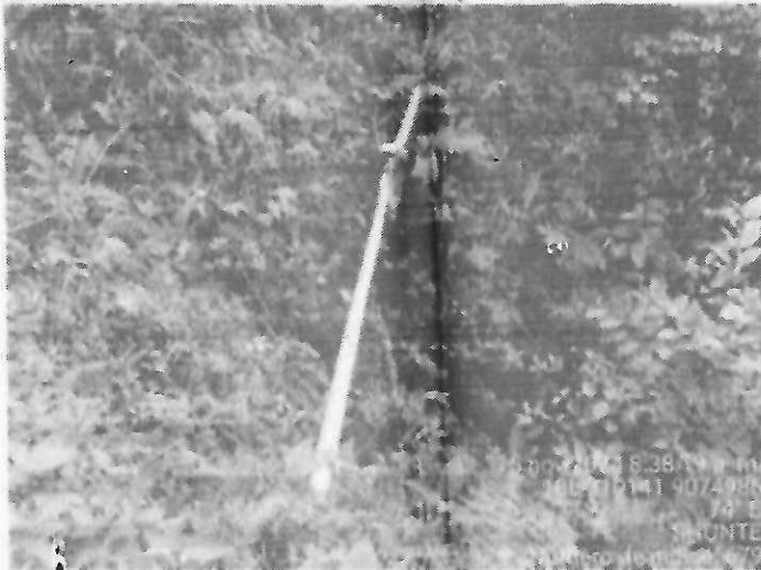
IMAGEN 13: línea de conducción afectada por deslizamientos
